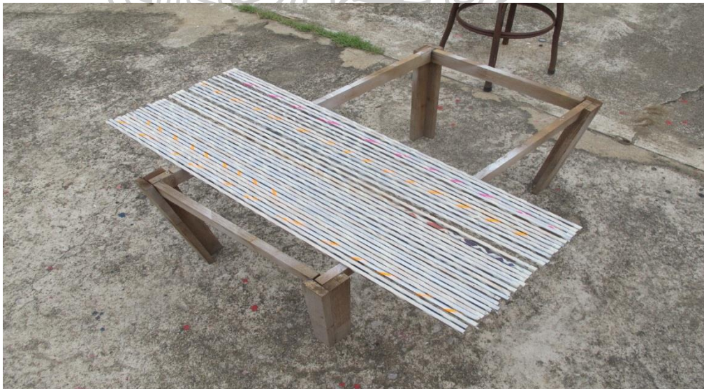
ภาพที่ 23 การเตรียมโครงเหล็ก ให้ได้ขนาดตามแบบ เตรียมโครงสร้างด้วยเหล็กเส้น ให้ได้ขนาดตามแบบที่ต้องการสร้าง
