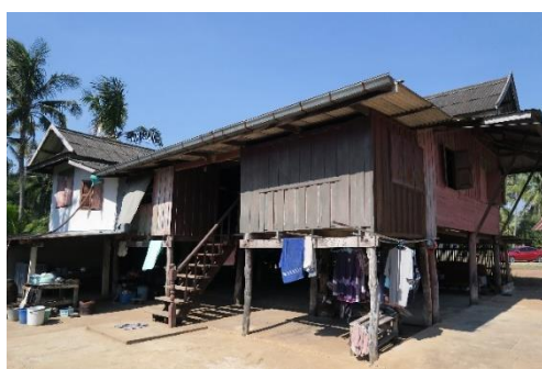
รูปที่ 19 เรือนกรณีศึกษาหลังที่ 2 ที่มีการต่อเติมชั้นบนและชั้นล่างด้วยการก่ออิฐกันห้อง
