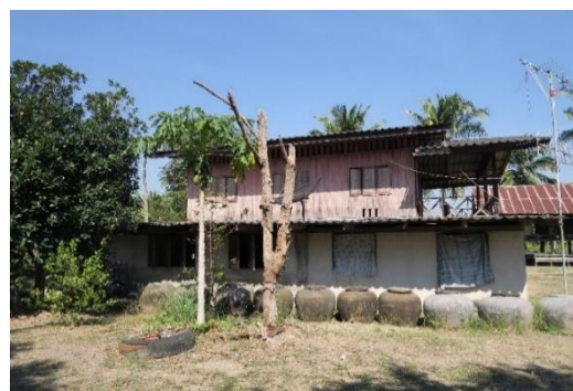
รูปที่ 7 การปรับปรุงและต่อเติมเรือนกรณีศึกษาหลังที่ 1 ด้วยการก่ออิฐที่บังกั้นพื้นที่บางส่วน
