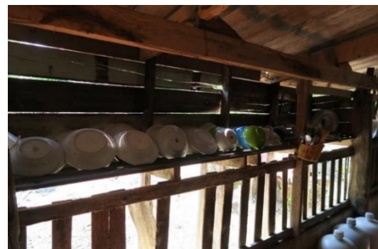
รูปที่ 79 การปรับปรุงและต่อเติมเรือนกรณีศึกษาหลังที่ 7 ด้วยการตีไม้ระแนงกั้นพื้นที่
