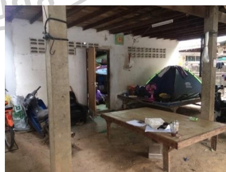
รูปที่ 116 การปรับปรุงต่อเติมเรือนกรณีศึกษาหลังที่ 10 ด้วยการก่ออิฐกันห้องที่ใต้ถุนเรือน
