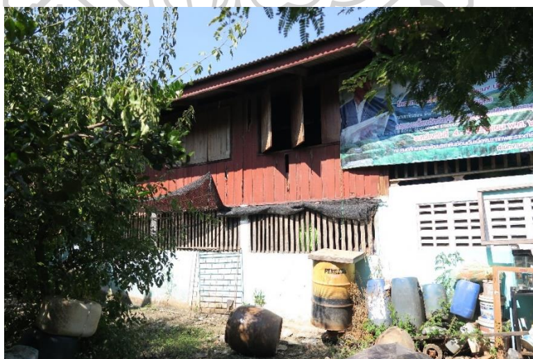
รูปที่ 228 การเปลี่ยนแปลงการใช้งานพื้นที่ใต้ถุนเรือนบ้านทุ่งเพื่อด้วยการปิดล้อมพื้นที่ใต้ถุนเรือน
