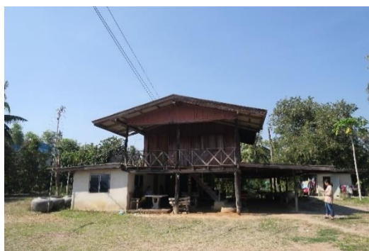
รูปที่ 7 การปรับปรุงและต่อเติมเรือนกรณีศึกษาหลังที่ 1 ด้วยการก่ออิฐที่บังกั้นพื้นที่บางส่วน
