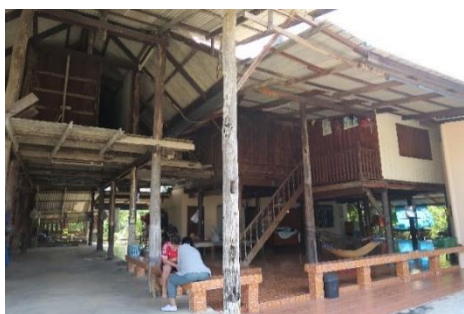
รูปที่ 31 การปรับปรุงและต่อเติมเรือนกรณีศึกษาหลังที่ 3 ด้วยการก่ออิฐกันห้อง
