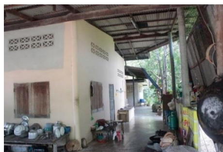
รูปที่ 31 การปรับปรุงและต่อเติมเรือนกรณีศึกษาหลังที่ 3 ด้วยการก่ออิฐกันห้อง
