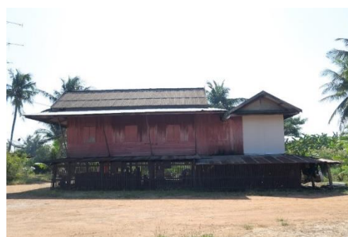
รูปที่ 19 เรือนกรณีศึกษาหลังที่ 2 ที่มีการต่อเติมชั้นบนและชั้นล่างด้วยการก่ออิฐกันห้อง
