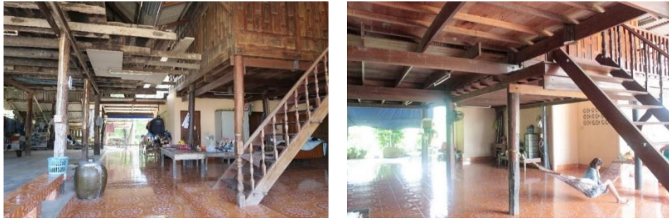
รูปที่ 33 การปรับปรุง ต่อเติมเรือนกรณีศึกษาหลังที่ 3 ด้วยการบูรณะเบื้องต้นเพิ่มพื้นที่ใช้งาน
