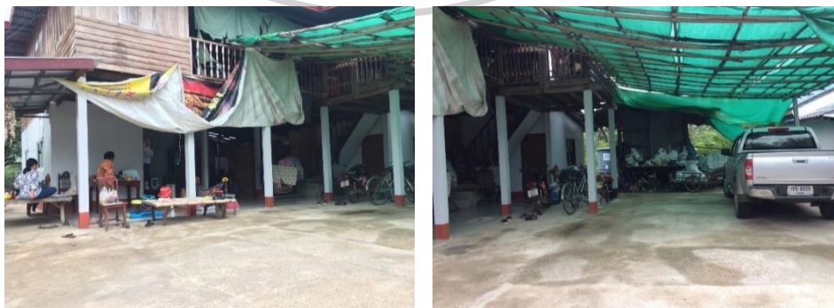
รูปที่ 153 การปรับปรุง ต่อเติมเรือนกรณีศึกษาหลังที่ 14 ด้วยการก่ออิฐกั้นห้อง (ซ้าย)
