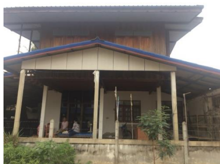
รูปที่ 104 การปรับปรุงต่อเติมเรือนกรณีศึกษาหลังที่ 9 ด้วยการก่ออิฐทับกันพื้นที่บางส่วน
