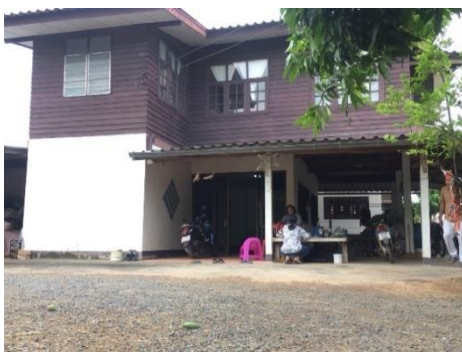
รูปที่ 92 การปรับปรุงและต่อเติมเรือนกรณีศึกษาหลังที่ 8 ด้วยการก่ออิฐทึบกั้นห้อง
