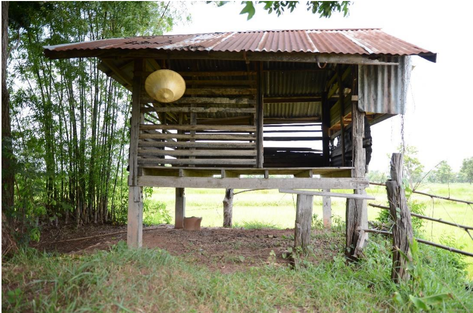
ภาพที่ 70 เถียงนารหัส TB01-3 เป็นเถียงนาที่ใช้เสาคอนกรีตต่อกับเสาไม้จริงเป็นเสาโครงสร้าง
