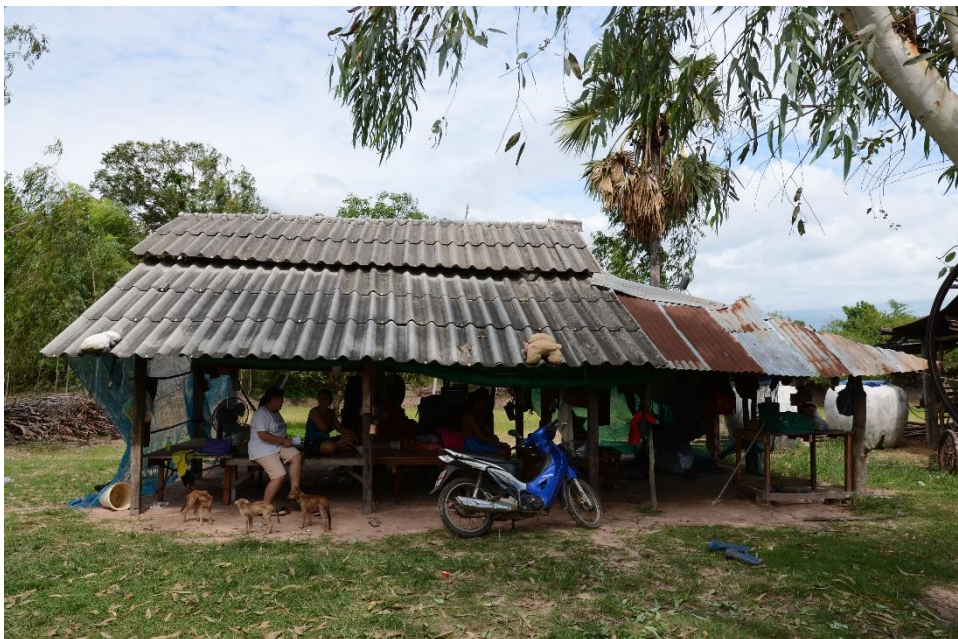
ภาพที่ 77 เถียงนาที่มีการใช้วัสดุถุงหลังคาด้วยกระเบื้องลอน และสังกะสี
