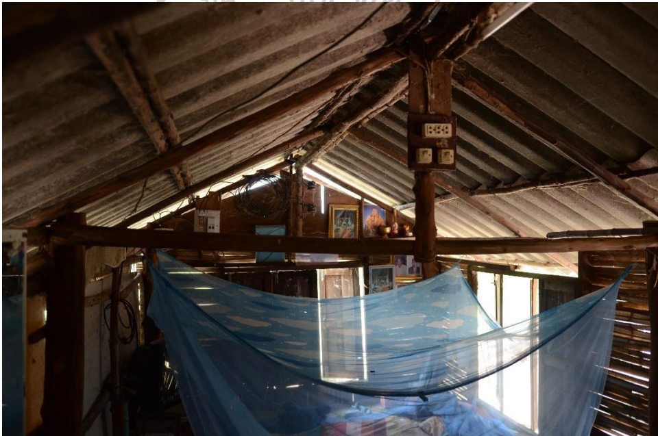
ภาพที่ 75 เกียงนารหัส TR02-3 โครงหลังคาที่สร้างจากวัสดุไม้ท่อนทั้งหมด
