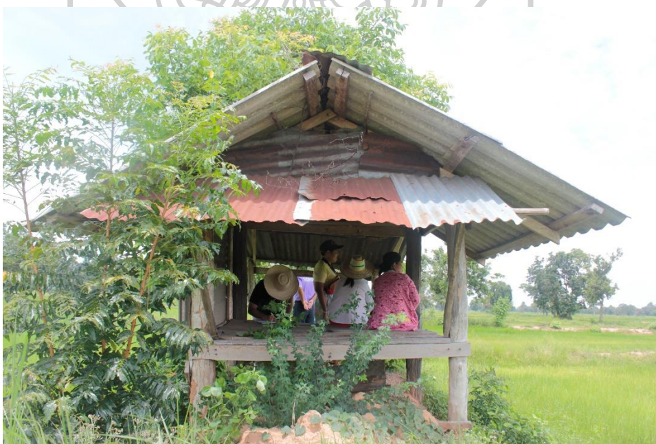
ภาพที่ 68 เถียงนารหัส TB01-2 เสาโครงสร้างใช้เป็นเสาไม้จริงทั้งลำต้น
