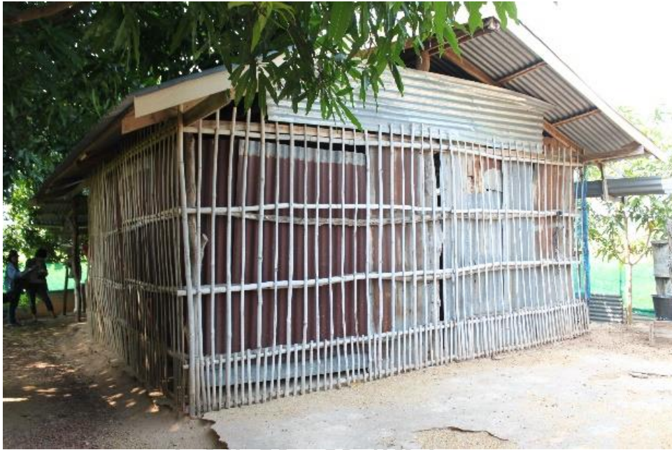
ภาพที่ 83 ลักษณะผนังของเถียงนารหัส TR01-4 ซึ่งมีการใช้งานวัสดุหลายชนิด
