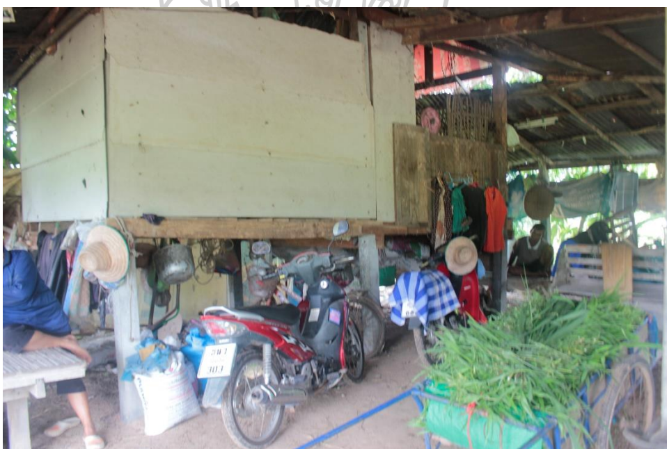
ภาพที่ 87 เถียงนารหัส TR01-2 ก่อผนังทึบเกือบตลอดทั้งหลัง เว้นพื้นที่เถียงนาด้านใน
