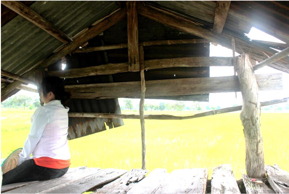
ภาพที่ 74 เกียงนารหัส TB01-4 โครงหลังคาที่ทำจากวัสดุไม้ท่อนและไม้แปรรูป
