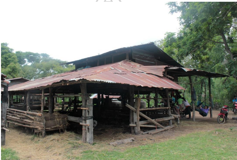
ภาพที่ 88 สังกะสีหลังคาเถียงนารหัส TB01-5 เป็นวัสดุเก่าที่ถ่ายถอดมาจากเรือนใหญ่ในหมู่บ้าน
