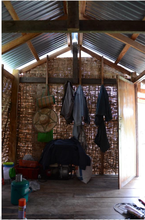
ภาพที่ 72 เถียงนารหัส TR01-1 ตัวอย่างโครงหลังคาที่ใช้วัสดุไม้ทรงสี่เหลี่ยมทั้งหมด
