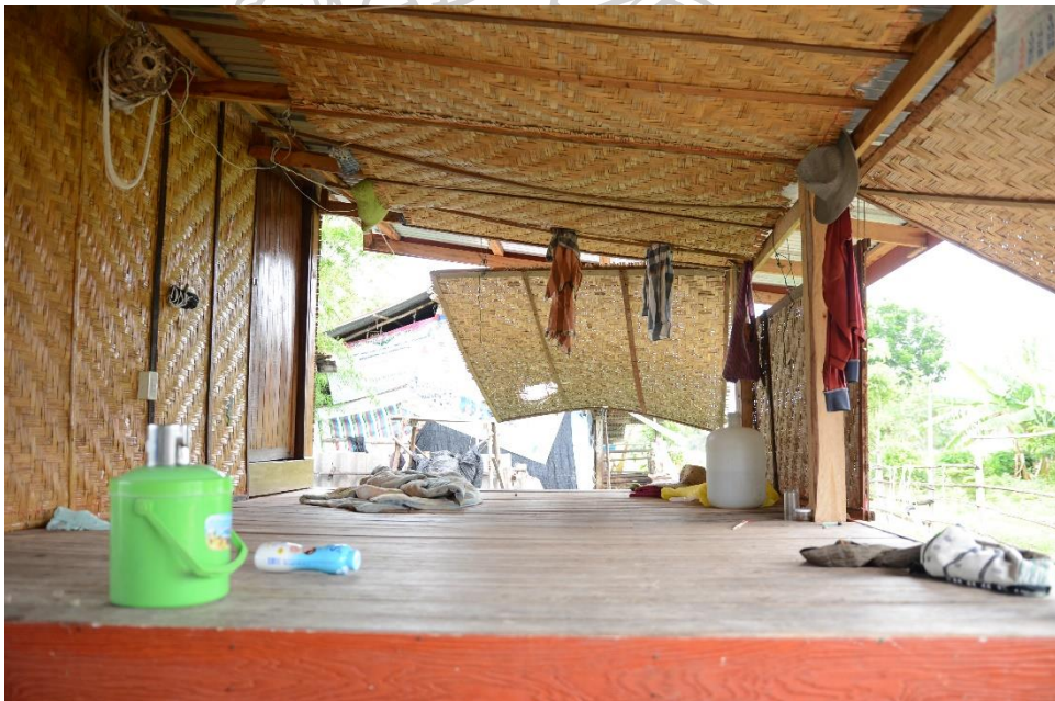
ภาพที่ 81 พื้นของเถียงนารหัส TR01-1 ปูด้วยแผ่นไม้กระดานที่ขัดเรียบทั้งสี่ด้าน มีขนาดไม้เท่ากัน ทำให้พื้นเรียบ ปลายของไม้ที่วางเรียงยาวเท่ากันทุกด้าน
