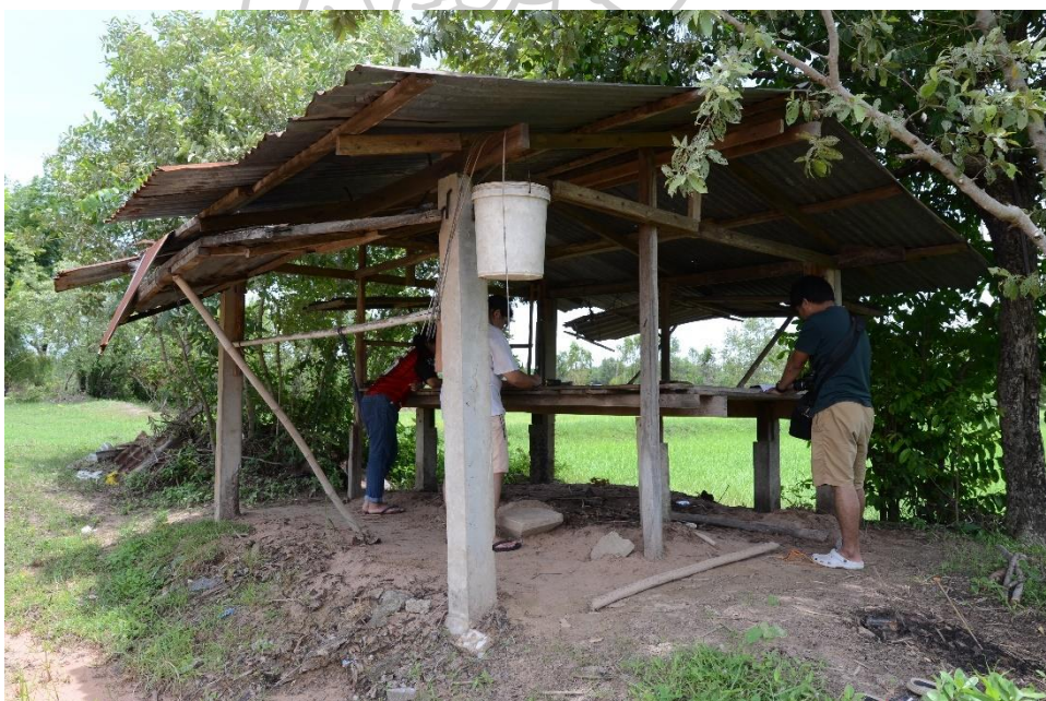
ภาพที่ 69 เถียงนารหัส TR02-2 ใช้เสาคอนกรีตเป็นเสาโครงสร้าง ระยะความสูงตั้งแต่พื้นดินจนถึงส่วนของโครงหลังคา
