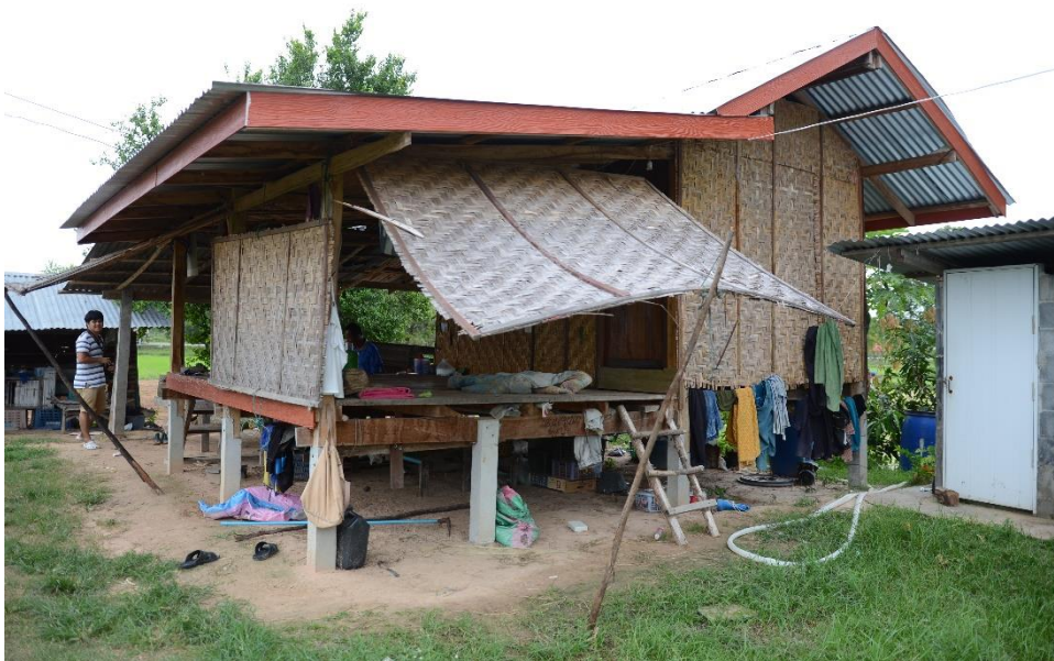
ภาพที่ 89 ลักษณะของเถียงนารหัส TR01-1 เป็นเถียงนาที่ก่อสร้างจากวัสดุใหม่ ไม่ได้เป็นวัสดุที่รับมาจากการสร้างหรือซ่อมแซมเรือนใหญ่
