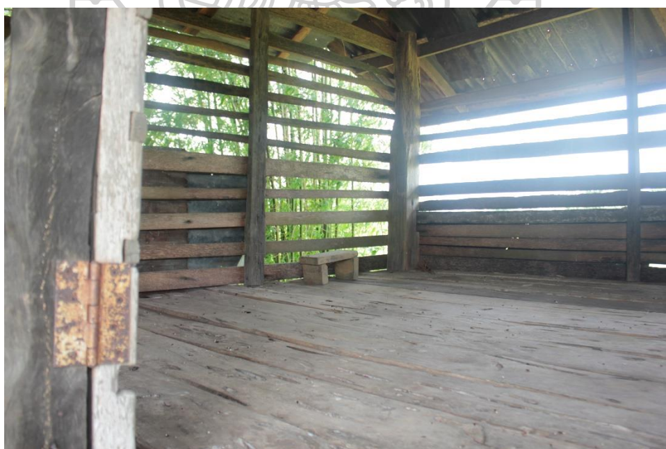
ภาพที่ 79 พื้นของเถียงนารหัส TB01-2 พื้นที่ถูกโดยไม้กระดานที่เหลือจากการสร้างเรือนใหญ่
