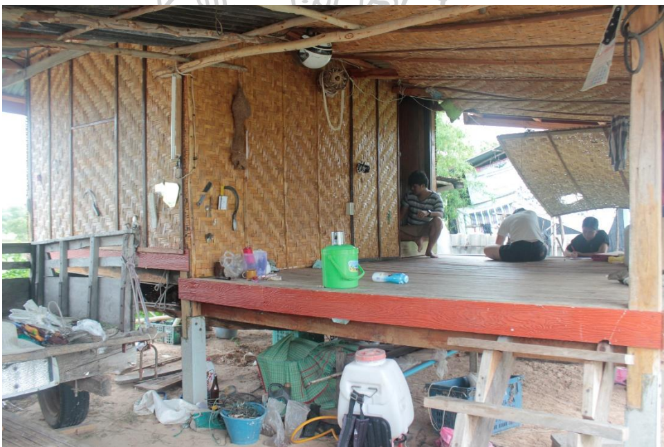
ภาพที่ 71 เถียงนารหัส TR01-1 ฐานล่างเป็นเสาคอนกรีตต่อด้วยเสาเข็มไม้
