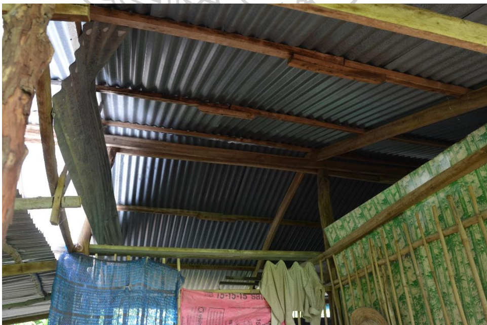
ภาพที่ 73 เถียงนารหัส TR01-4 ตัวอย่างโครงหลังคาที่ใช้วัสดุไม้แปรรูปทั้งหมด
