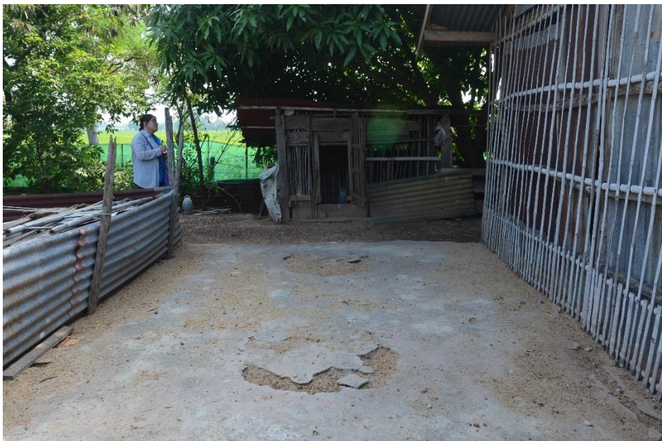
ภาพที่ 82 พื้นของเถียงรหัส TR01-4 มีการเทปูนซีเมนต์ลงบนพื้นดิน
