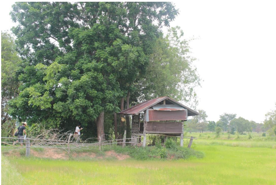
ภาพที่ 86 เถียงนารหัส TB01-3 ผนังด้านที่หันมาทางถนนเข้าออกพื้นที่ศึกษาปิดทึบด้วยแผ่นสังกะสี
