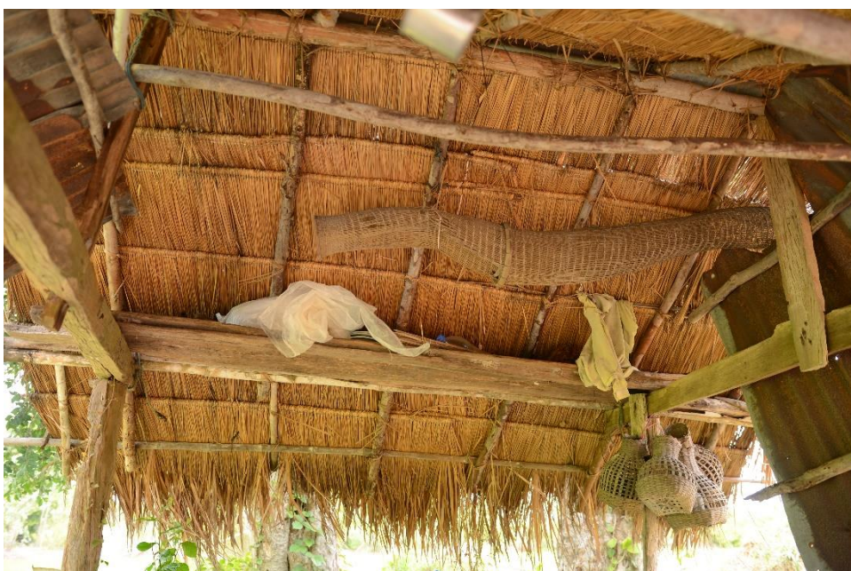
ภาพที่ 76 ลักษณะโครงสร้างหลังคามุงหญ้าคา
