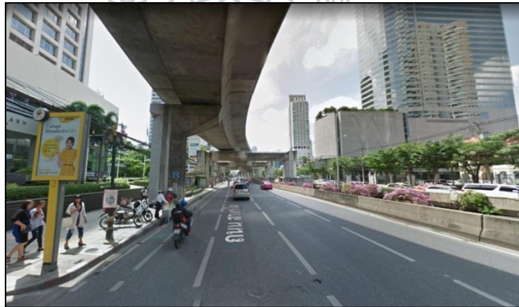
ภาพที่ 25 แสดงภาพถนนสาทร ช่วงที่ 2 แยกนราธิวาสราชนครินทร์ถึงแยกเจริญราษฎร์
