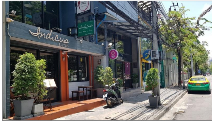
ภาพที่ 54 แสดงการใช้ประโยชน์พื้นที่อาคารข้างเคียงในถนนหลังสวน
