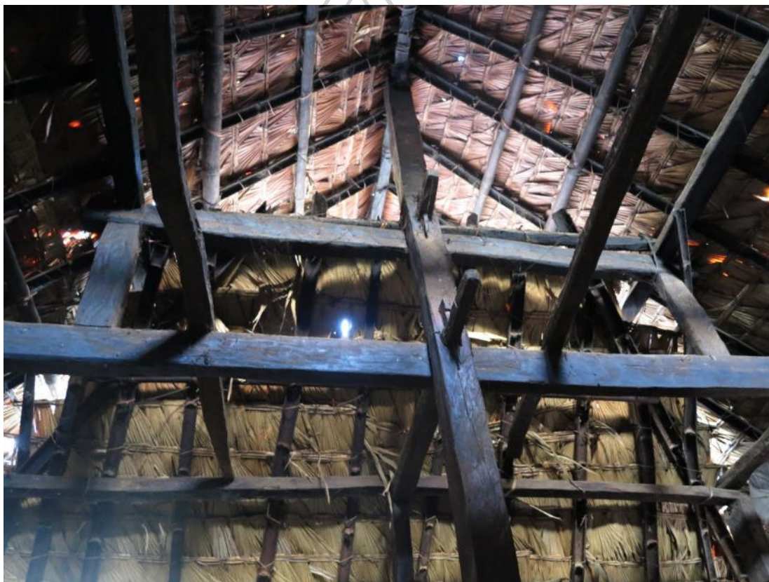
ภาพที่ 110: โครงสร้างเรือนโถม
