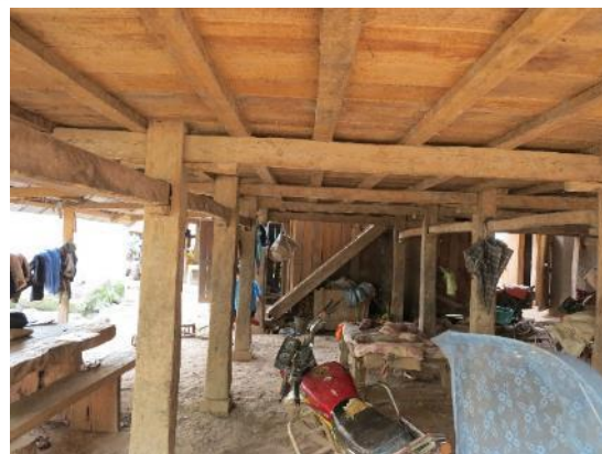
ภาพที่ 123: โครงสร้างใต้ถุนเรือนโย
