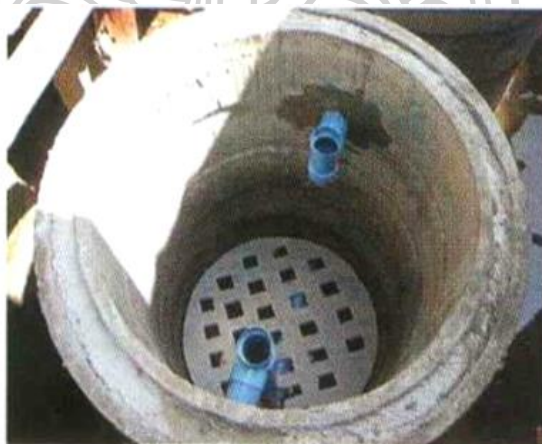
รูปที่ 10 ตัวอย่างบ่อกรองไร้อากาศ ที่มา : (ชาติ เจริญไชยศรี, 2550)
