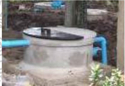
รูปที่ 4 บ่อดักไขมันและฝาปิดแบบวงขอบซีเมนต์
