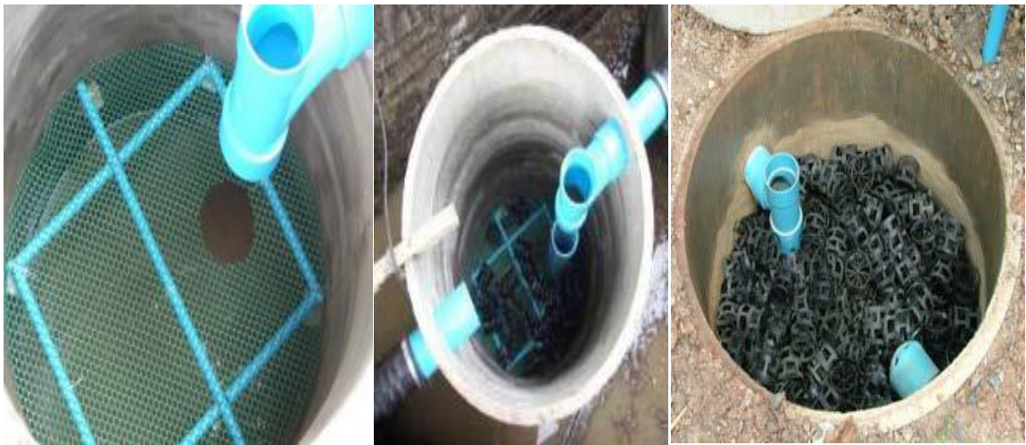
รูปที่ 9 การติดตั้งชั้นตัวกลางภายในบ่อกรองไร้อากาศ ที่มา : (กรมควบคุมมลพิษ, 2555)
