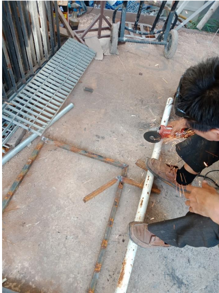
ภาพที่ 43 ภาพการตัดเศษเหล็กเหลือใช้และเหล็กผูกมาเชื่อมประกอบเป็นขาตั้ง
