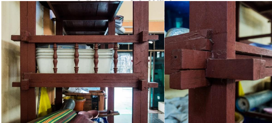
รูปที่ 148: ภาพรายละเอียดรอยต่อชั้นวางของที่ทำจากเถรอตเพล
