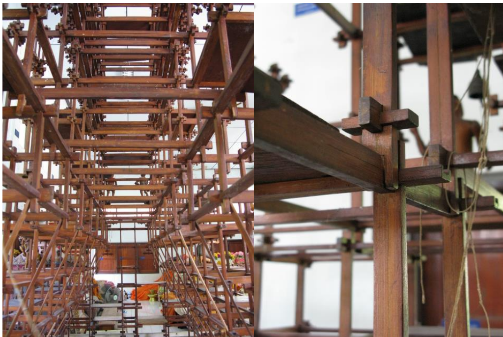
รูปที่ 153: การเว้นที่ว่างตรงกลางบริเวณฐาน (ซ้าย) เทคนิคการต่อไม้แบบง่ายๆ(ขวา)
