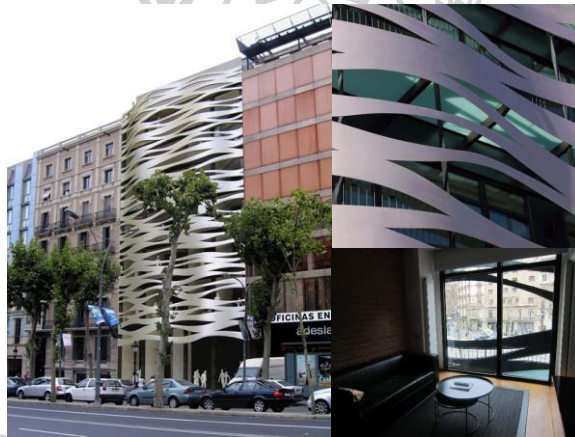
ภาพที่ 33 อาคาร Suites Avenue Aparthotel
