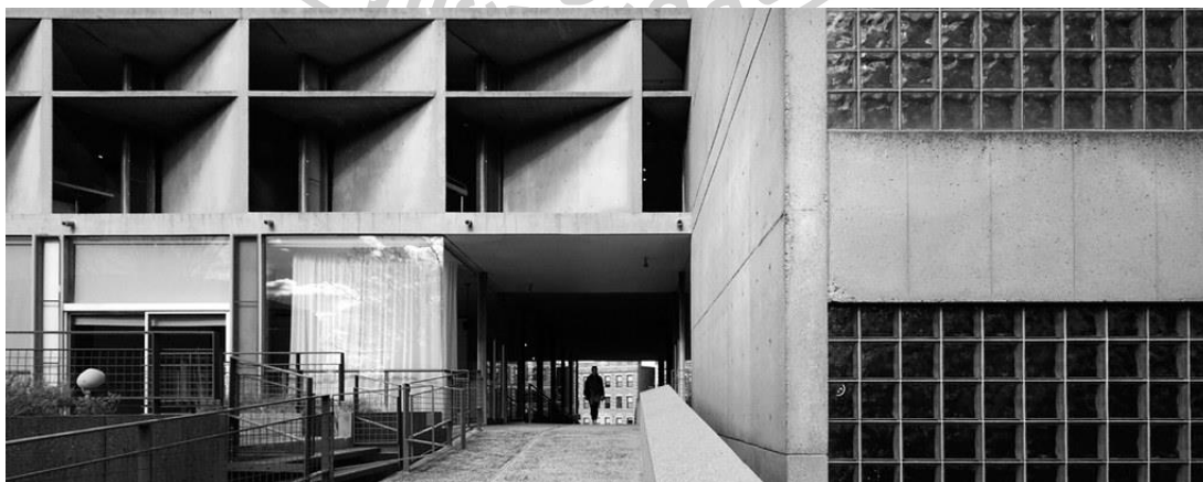
ภาพที่ 37 บรรยากาศอาคาร บริเวณทางลาดที่เห็นการใช้ผนังกระจกใส และผนังบล็อกแก้วโปร่งแสง ที่มา https://www.flickr.com/photos/h_ssan/17305636532
