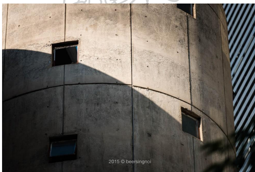
ภาพที่ 84 หน้าต่างสี่เหลี่ยมของโถงบันได ที่มา https://beersingnoi.com/2015/12/09/physics-bldg-1969/
