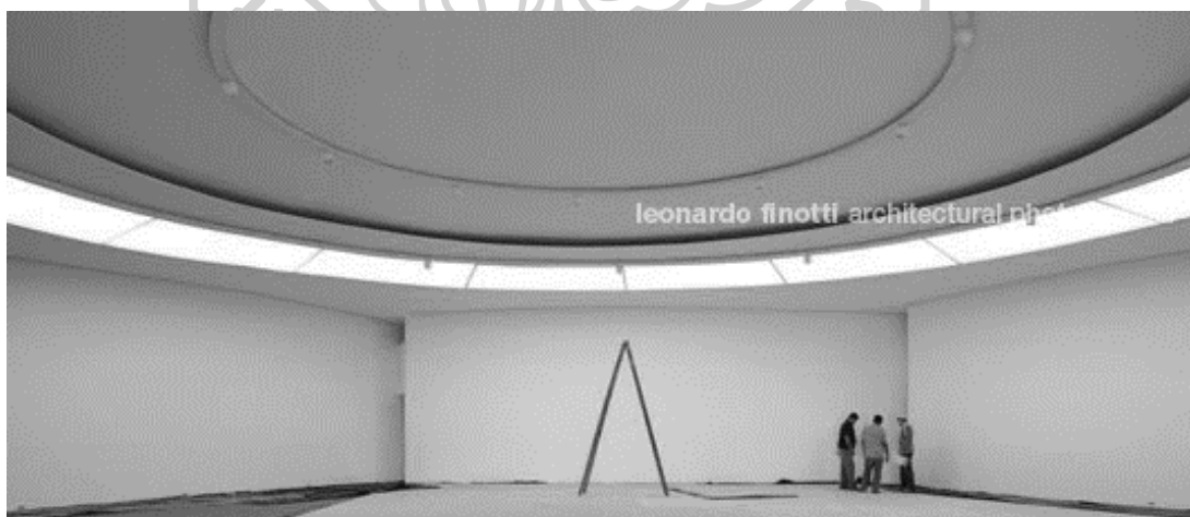
ภาพที่ 52 โถงกลางอาคาร
