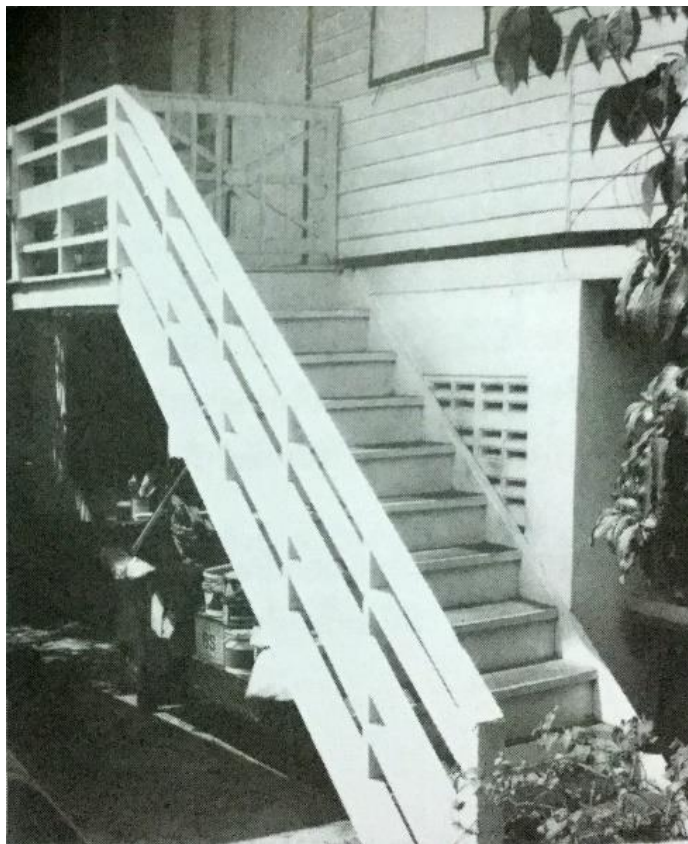
ภาพที่ 60 ภาพแสดง บ้านใดภายนอกอาคารสงเคราะห์พิบูลเวศม์ สุขุมวิท 71 190
