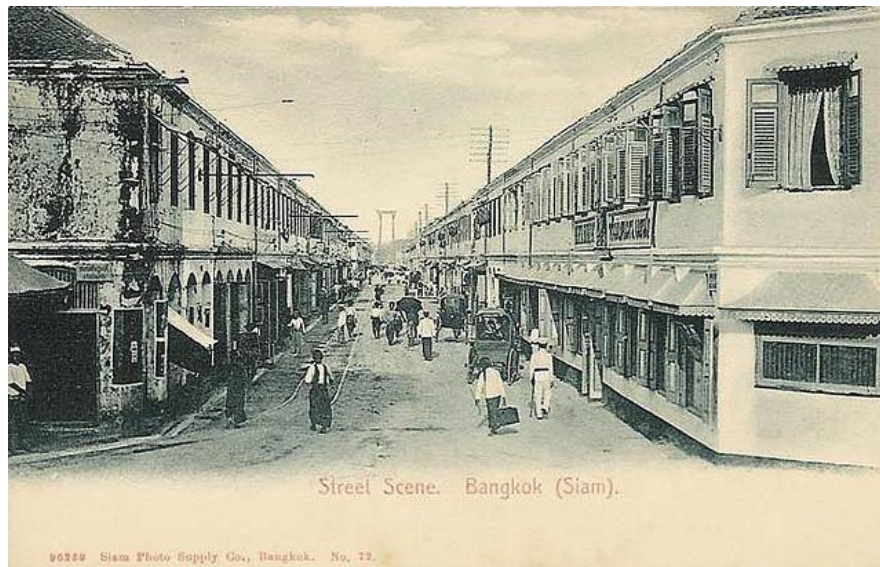
ภาพที่ 40 ตึกแถวถนนบำรุงเมือง ในเขตคลองรอบกรุง 159
