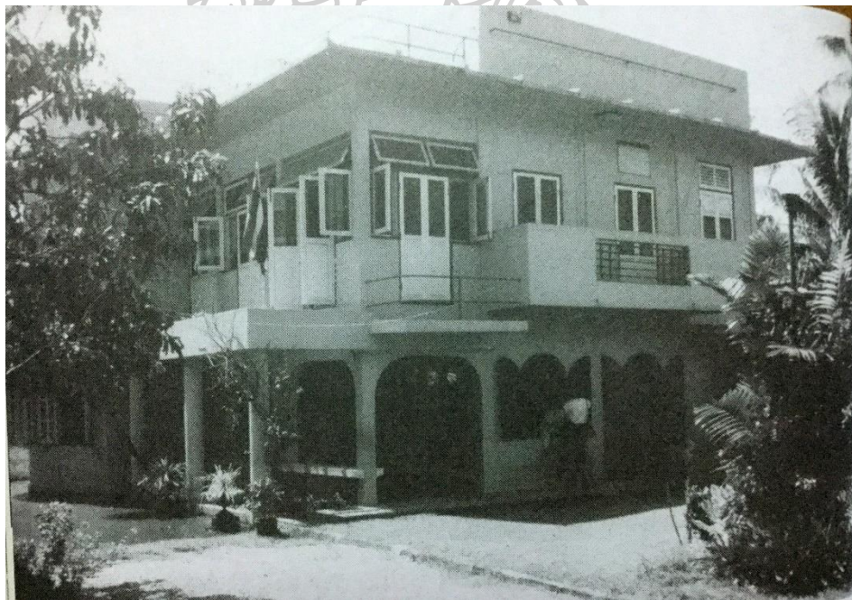
ภาพที่ 53 บ้านพระสาโรชรัตนนิมมานก์ มีการใช้หลังคาแบน(Flat slab) 180
