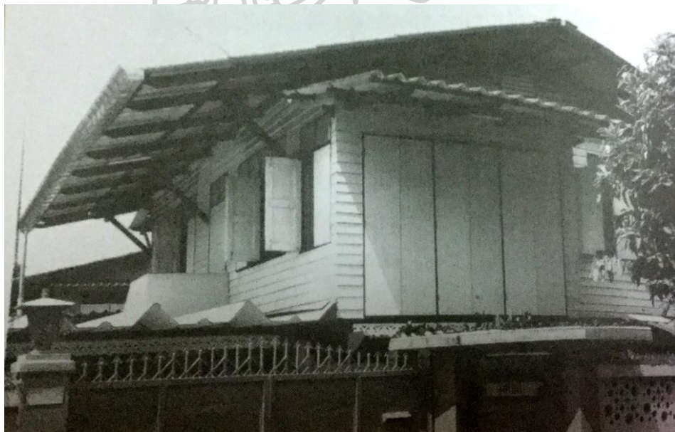
ภาพที่ 57 อาคารสงเคราะห์พิบูลวัฒนา ถนนพระรามที่ 6 187
