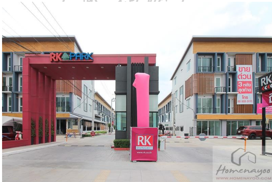
ภาพที่ 76 ทางเข้าโครงการ อาร์เค พาร์ค วัชรพล RK PARK Watcharapol ถนนสายไหม แขวงสายไหม เขตสายไหม กรุงเทพมหานคร 211
