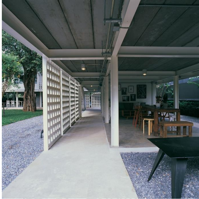
รูปที่ 55 แผงผนังอิฐช่องลมและองค์ประกอบของใต้ถุนเรือน กรณีศึกษา C 07
