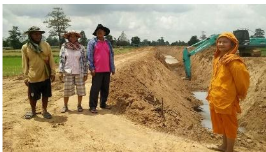
การขุดสระเชื่อมคลองแก้มลิง
