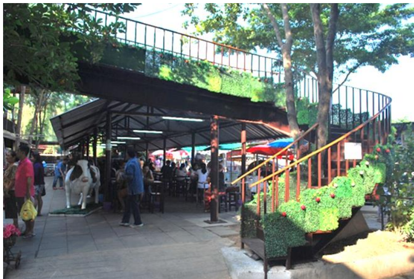
ภาพที่ 106 บันไดใหม่ที่สร้างขึ้นบริเวณทิศเหนือของอาคารสองชั้น (หมายเลข 5) เพื่อเชื่อมขึ้นไปยังชั้นบนของอาคารนี้
