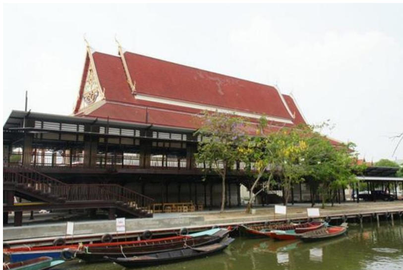
ภาพที่ 115 แสดงลักษณะของอาคารสองชั้น (หมายเลข 2) ตลาดน้ำขวัญเรียมฝั่งเหนือ ที่มา: www.kapook.com , ตลาดขวัญเรียม แหล่งวัฒนธรรมริมคลองแสนแสบ, เข้าถึงเมื่อ 9 ธันวาคม 2558, เข้าถึงได้จาก http://travel.kapook.com/view41016.html
