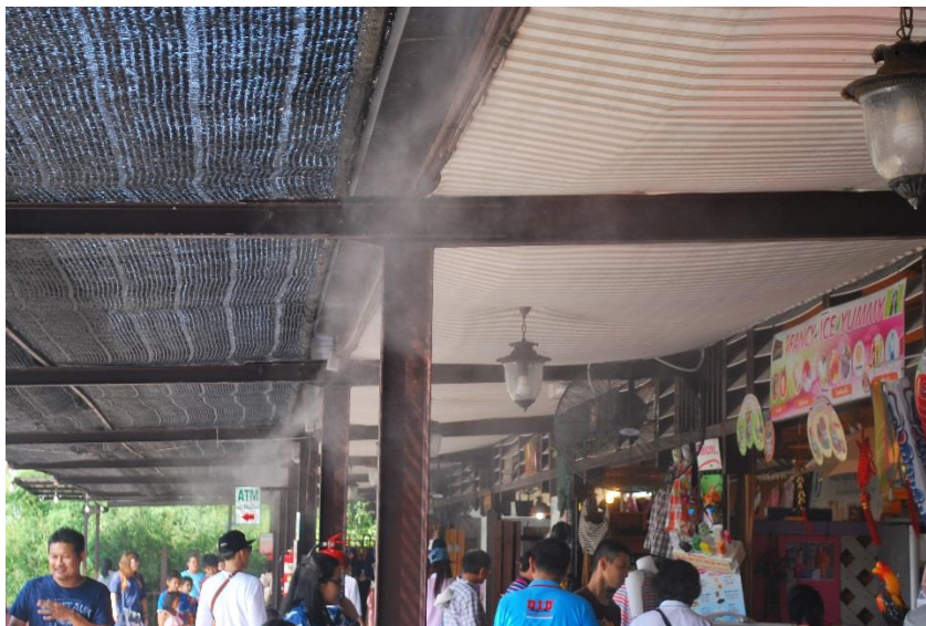
ภาพที่ 117 แสดงการติดตั้งพัดลมและระบบไอน้ำบริเวณชั้นบนของอาคารสองชั้น ตลาดน้ำขวัญเรียม ฝิ่งเหนือ ทั้งนี้เพื่อเป็นลดความร้อนของอากาศและทำให้พื้นที่มีความเย็นสบาย
