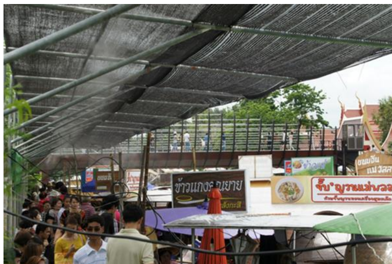
ภาพที่ 58 บริเวณตรอกเรือมีการติดตั้งตาข่ายพรางแสงและติดตั้งระบบไอน้ำ เพื่อเพิ่มอุณหภูมิให้พื้นที่มีความเย็นสบายขึ้น
