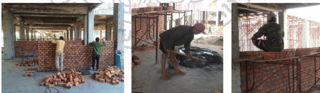
ภาพที่ 29 การจำแนกลักษณะการทำงานก่ออิฐรวมเสาเอ็น คานเอนของชุดคณงาน
