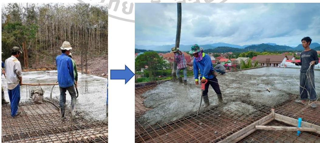
ภาพที่ 33 เครื่องจักรคอนกรีตแบบยกสองคน มาเป็นเครื่องจักรคอนกรีตแบบใช้ไฟฟ้ายกด้วย 1 คน
