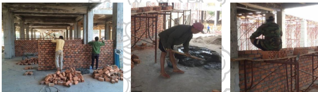
ภาพที่ 28 การจำแนกลักษณะการทำงานก่ออิฐผนังที่ไม่รวมเสาเอ็น คานเอ็นของชุดคานงาน
