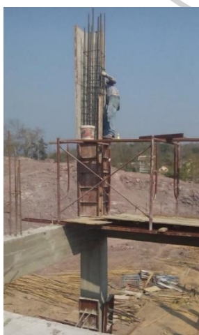
ภาพที่ 31 ลักษณะการทำงานที่ช่องเปิดบันไดที่ทำงานไม่สะดวก
