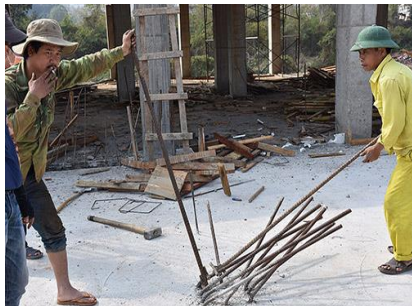
ภาพที่ 32 การแก้ไขเหล็กไม่ตรงตำแหน่ง
