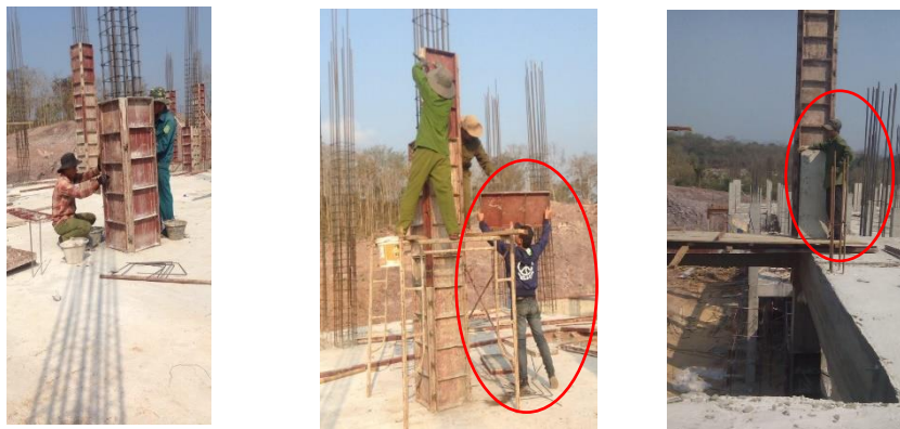
ภาพที่ 25 การจำแนกลักษณะการทำงานเข้าแบบเหล็กเสาของชุดคณงาน
