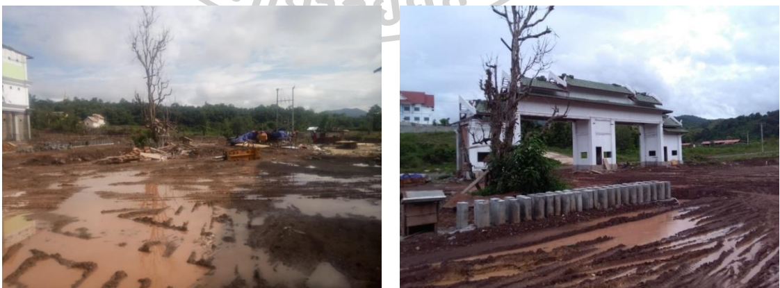
ภาพที่ 6 สภาพหน้างาน ขาดการกำหนดเส้นทางขนส่งในไซต์ที่ชัดเจน น้ำท่วมขังในไซต์งาน
