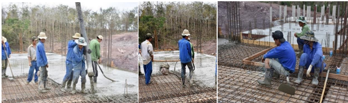
ภาพที่ 27 การจำแนกลักษณะการทำงานเทคนิคกรีดพื้นของชุดคนงาน
