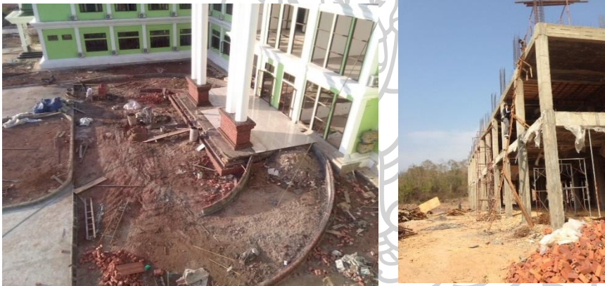
ภาพที่ 5 สภาพหน้างานรอกการขนย้ายกองวัสดุเพื่อเคลียร์เส้นทางให้รถขนส่งเข้าพื้นที่
