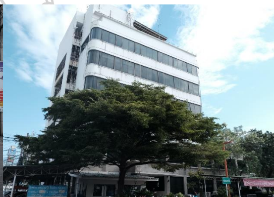
ภาพที่ 34 อาคารสำนักงานตลาดบางใหญ่
