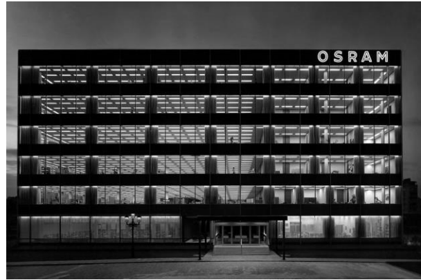
Fig 3. 100 รูปด้านอาคาร Osram Offices
