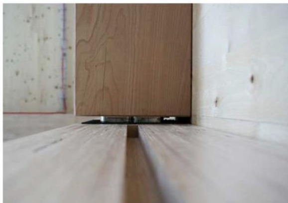
Fig 4. 22 รายละเอียดรอยต่อโครงสร้าง
