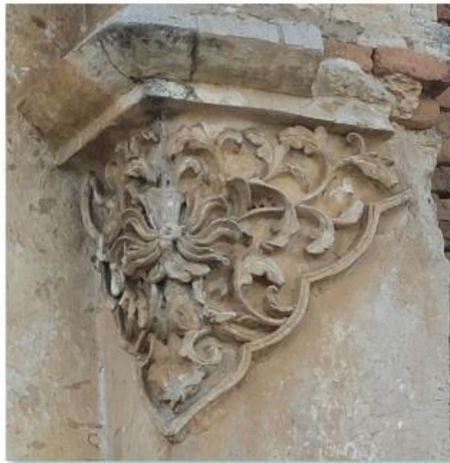
ภาพถ่ายลวดลายปูนปั้นประดับบริเวณกาบบนของเสาซุ้มจระนำชั้นในด้านทิศตะวันออก
