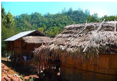
ภาพที่ 125 การนำหญ้ามามุงหลังคา
