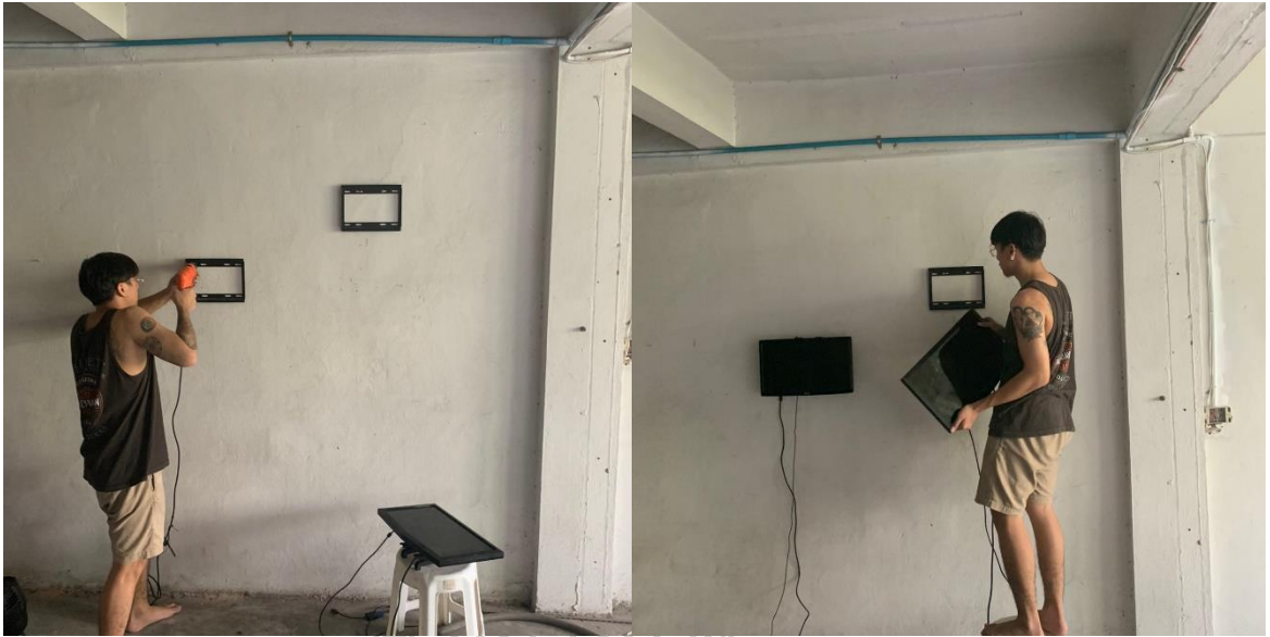
ภาพที่ 61 มาร์คตำแหน่งโดยให้ตลับเมตรและระดับน้ำ ทำการเจาะยึดตัวรับขาจอและแขนจอภาพ
