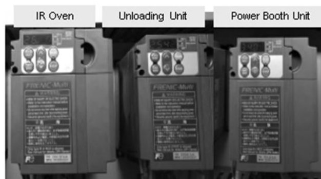
รูปที่ 41 อุปกรณ์อ่านค่าความเร็วสายพานในตู้ควบคุม
