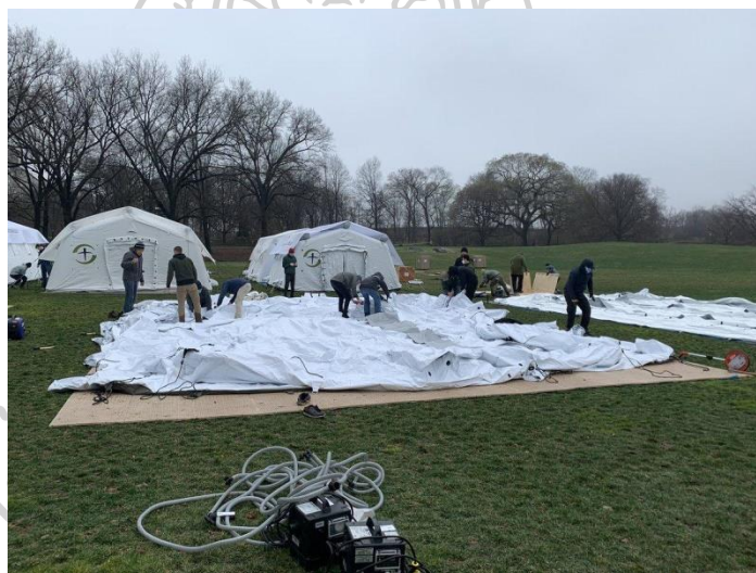
ภาพที่ 42 แสดงการป้อนลมเข้าไปในโครงสร้าง
