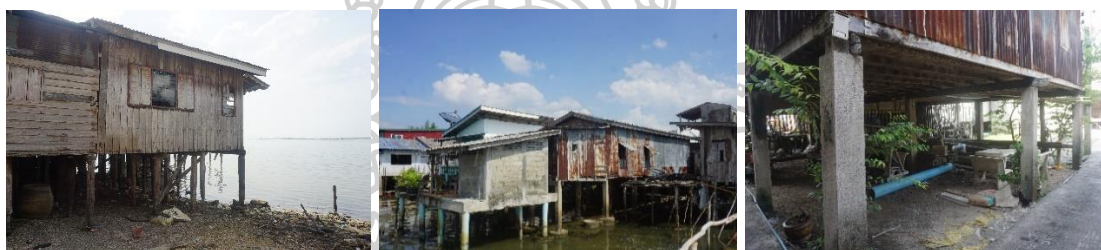
ภาพที่ 32 แสดงลักษณะของเรือนไม้ยกใต้ถุนสูง
