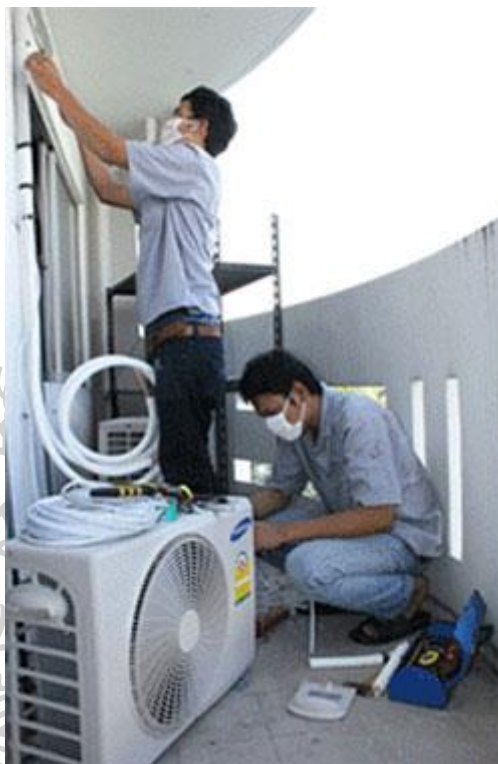
รูปที่ 3.7 แสดงการติดตั้งเครื่องปรับอากาศ
