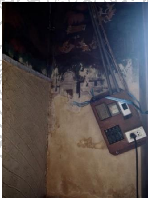
ภาพที่ 19 การต่อวงจรไฟฟ้าติดกับภาพจิตรกรรมฝาผนัง ตัวอย่างจากวัดกำแพง กรุงเทพมหานคร
