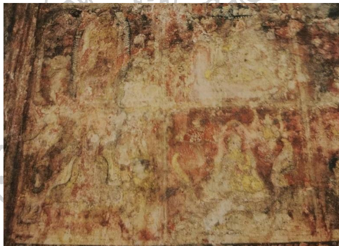
ภาพที่ 74 ชั้นสีโป่งพองและสีซีดจาง จิตรกรรมฝาผนัง กรุชั้นล่าง (ที่มาภาพ: กลุ่มอนุรักษ์จิตรกรรมและประติมากรรม, (2563), รายงานการสำรวจสภาพจิตรกรรมฝาผนังกรุพระปราสาทวัดราชบูรณะ.)
