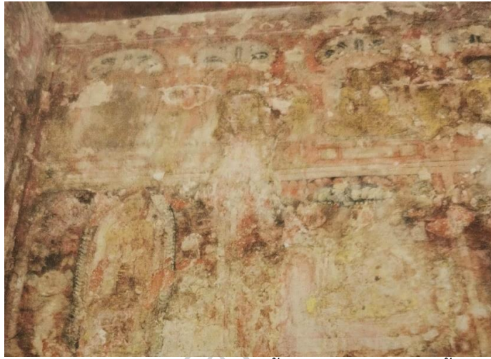
ภาพที่ 75 สภาพความชำรุดของจิตรกรรมฝาผนัง กรุชั้นล่าง ความชำรุดของชั้นสีโป่งพองและสีซีดจาง (ที่มาภาพ: กลุ่มอนุรักษ์จิตรกรรมและประติมากรรม, (2563), รายงานการสำรวจสภาพจิตรกรรมฝาผนังกรุพระปรางค์วัดราชบูรณะ.)
