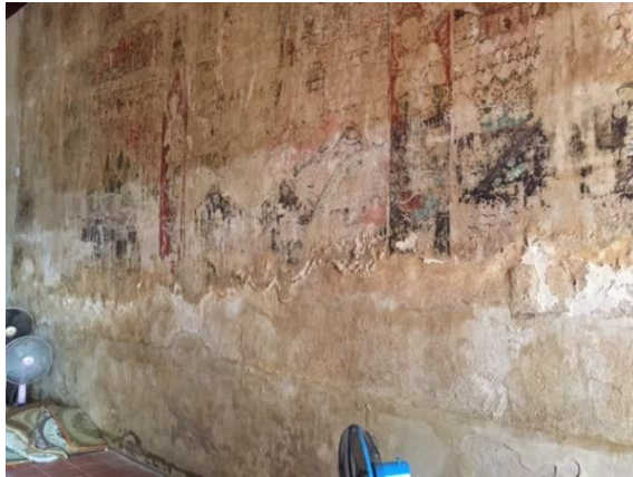
ภาพที่ 14 ความเสียหายจากเกลือบนผนังพระอุโบสถ วัดกำแพง
