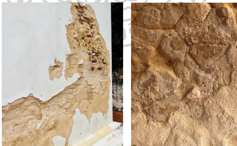
ภาพที่ 16 ผนังภายนอกที่เสื่อมสภาพจากเกลือ
