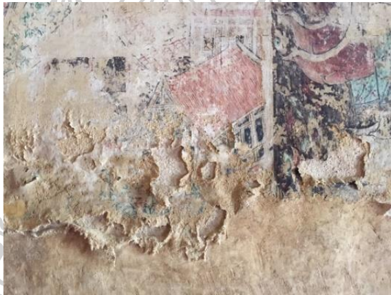
ภาพที่ 15 คราบเกลือที่พบบนผนังพระอุโบสถวัดกำแพง
