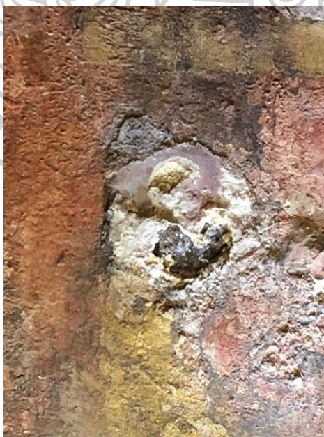
ภาพที่ 97 คราบเกลือบนผนังด้านทิศใต้ กรุชั้นล่าง
