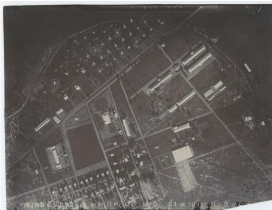
ภาพที่ 165 แสดงภาพถ่ายทางอากาศโรงพยาบาล กองพลที่ 5 มณฑลนครราชสีมา ที่มา : หอสมุดวชิรญาณ สำนักหอจดหมายเหตุแห่งชาติ
