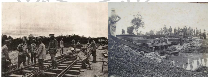
ภาพที่ 113 ทหารช่างรถไฟ วางรางรถไฟทำข้าง จ.นครราชสีมา ระหว่างทางรถไฟสาย
