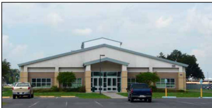
ภาพที่ 50 แสดงค่ายทหารที่ NAS JRB New Orleans Louisiana ออกแบบโดยใช้เทคโนโลยี BIM 244
