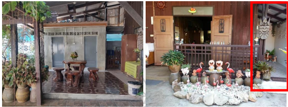
ภาพที่ 38 : การต่อเติมห้องน้ำบริเวณทิศใต้และบริเวณทิศเหนือติดกับตัวบ้าน
