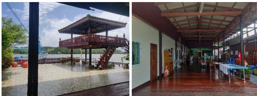
ภาพที่ 65 : บริเวณริมน้ำและบริเวณโถงที่มีการกั้นผนังทำเป็นห้องพัก
