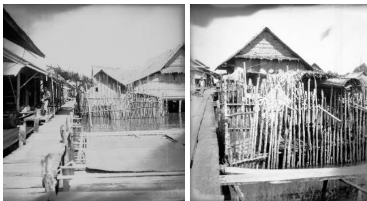
ภาพที่ 19 : สะพานไม้เดิมที่ใช้สัญจรภายในชุมชน
