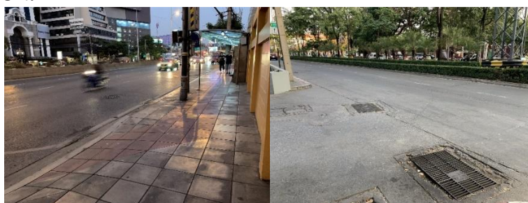
รูปที่ 79 แสดง ขนาดเส้นทาง และฝาท่อระบายน้ำที่เป็นอุปสรรค
