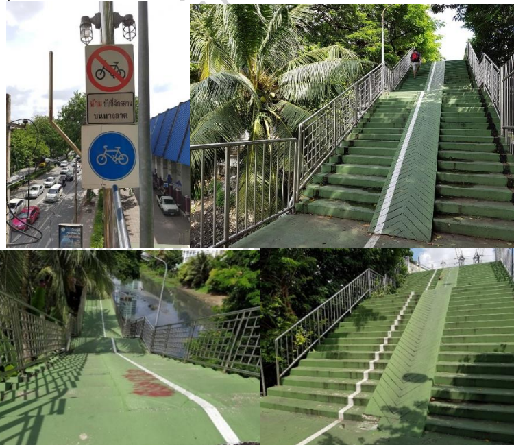
รูปที่ 96 แสดงบันไดพร้อมทางลาดเพื่อขึ้นจักรยานขึ้นลง เพื่อความปลอดภัยผู้ใช้จักรยานต้องขึ้นจักรยานขึ้นลงเท่านั้น
