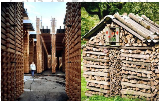
รูปที่ 52 แสดงวิธีการก่อสร้างของ Swiss Sound Box Pavilion ที่ลอกเลียนแบบวิธี Air-Drying Stack
