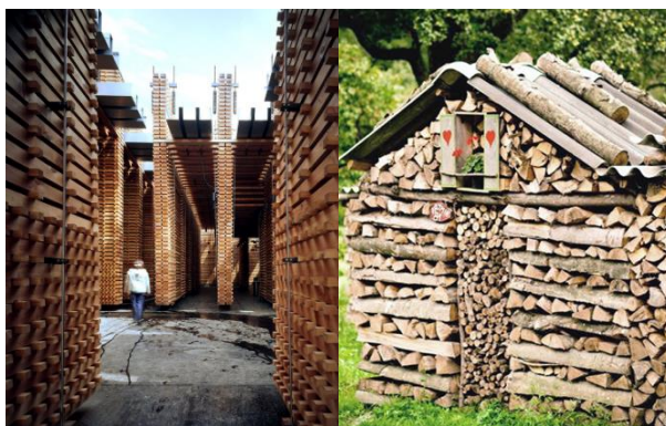
รูปที่ 31 แสดงเปรียบเทียบวิธีการก่อสร้างของ Swiss Sound Box Pavilion กับ Air-Drying Stack
