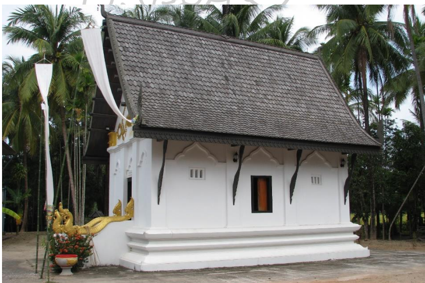
ภาพที่ 412 ตัวอย่าง งานประดับพญานาคบนราวบันไดสิมอีสาน
