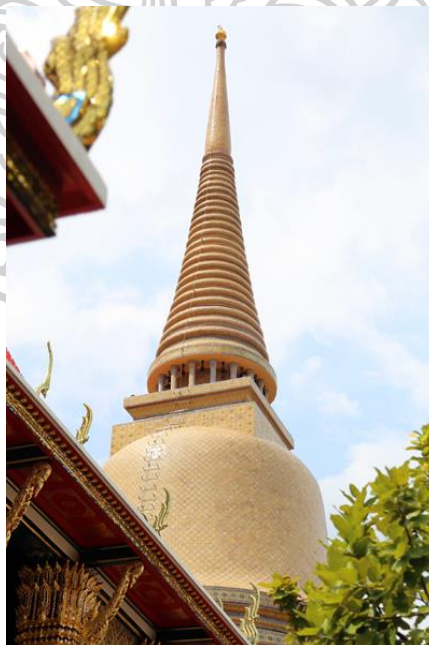
ภาพที่ 48 การประดับกระเบื้องส่วนองค์ระฆังขึ้นไปจนถึงยอดเจดีย์ วัดราชบพิธสถิตมหาสีมาราม
