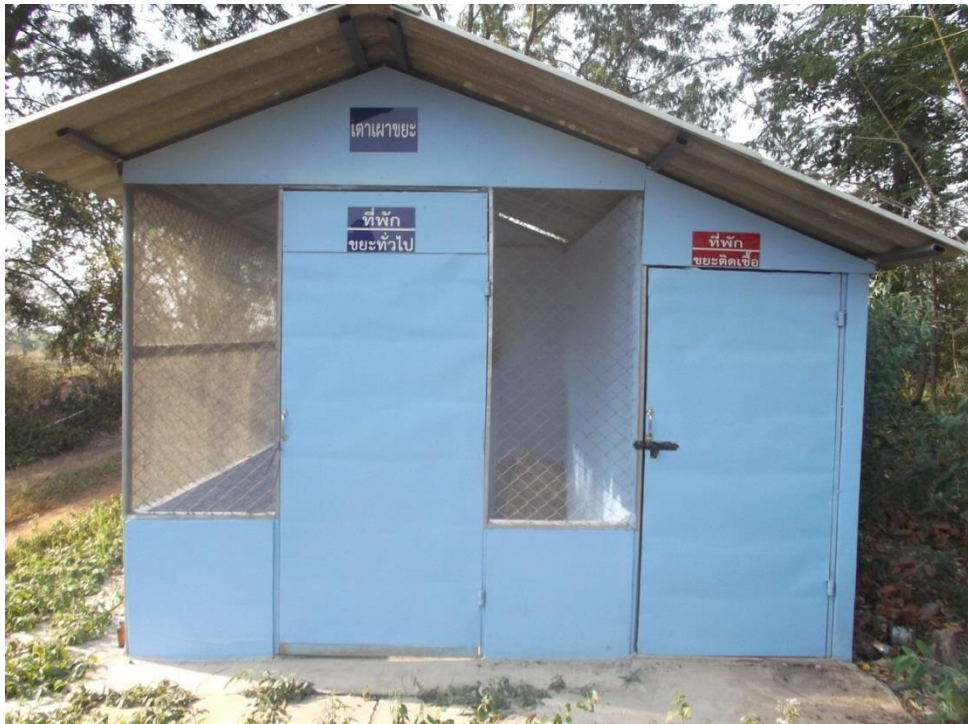
รูปที่ 2.3 จัดเก็บมูลฝอยติดเชื้อไว้ที่พักมูลฝอยติดเชื้อที่ถูกหลักสุขาภิบาล
