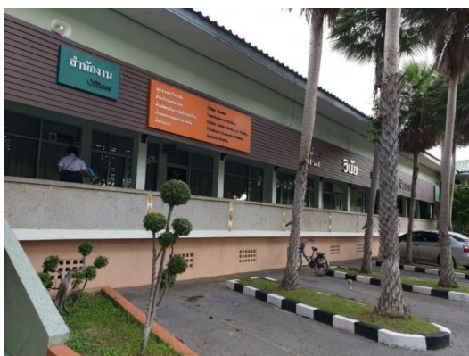
ก. อาคารสำนักงาน
