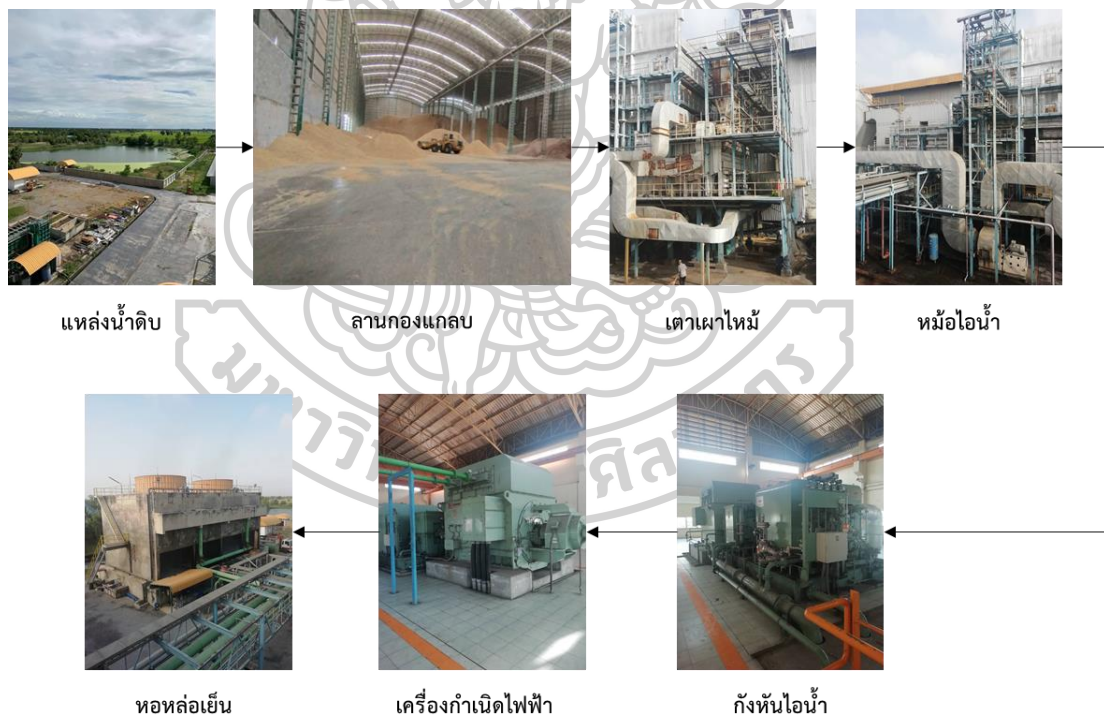
ภาพที่ 11 กระบวนการผลิตกระแสไฟฟ้าจากชีวมวล
