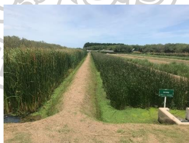
ภาพที่ 37 การบำบัดน้ำเสียด้วยระบบพื้นที่ชุ่มน้ำเทียม เป็นพื้นที่ที่เปียกชุ่ม หรือพื้นที่ที่มีน้ำขัง
