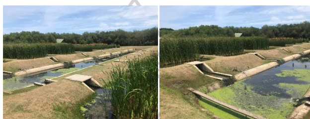
ภาพที่ 36 การบำบัดน้ำเสียด้วยระบบการใช้พืชและหญ้าในการกรองน้ำเสีย
