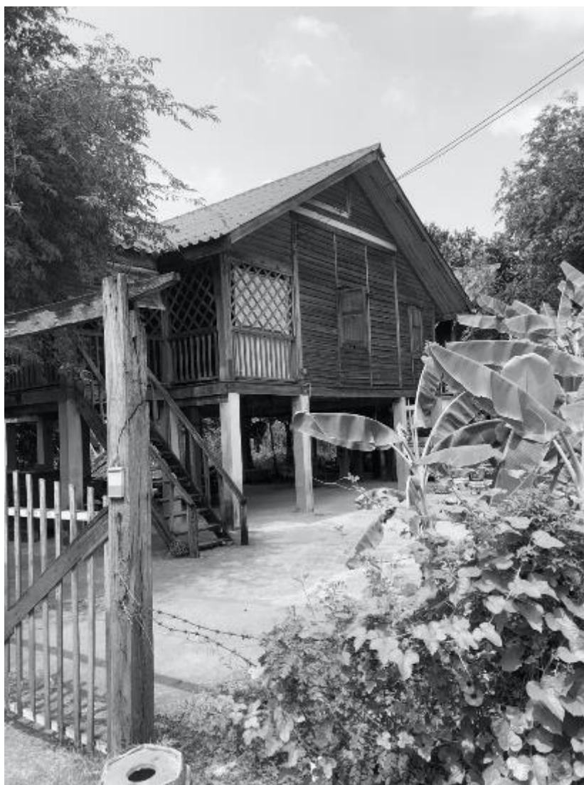
ภาพที่ 34 อาคารไม้อายุมากกว่า 70 ปี
