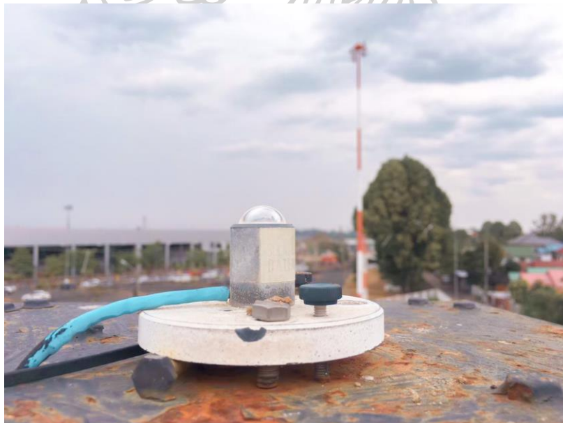
รูปที่ 35 เครื่องความเข้มแสงสว่างที่ติดตั้งที่ศูนย์อุตสาหกรรมวิทยภาคตะวันออกเฉียงเหนือ จังหวัดอุบลราชธานี
