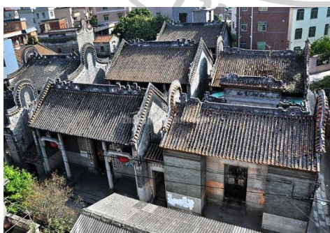
(82ก) หน้าบ้านทรงสามเหลี่ยม (ทรงจั่ว) และทรงวงโค้ง (ทรงหูกะทะ) ของบ้านโบราณในแถบเมืองกวางเจา (ที่มา : https://line.17qq.com/article/clpgnkhlv_p7.html/ เข้าถึงเมื่อวันที่ 14 กุมภาพันธ์ 2564)
