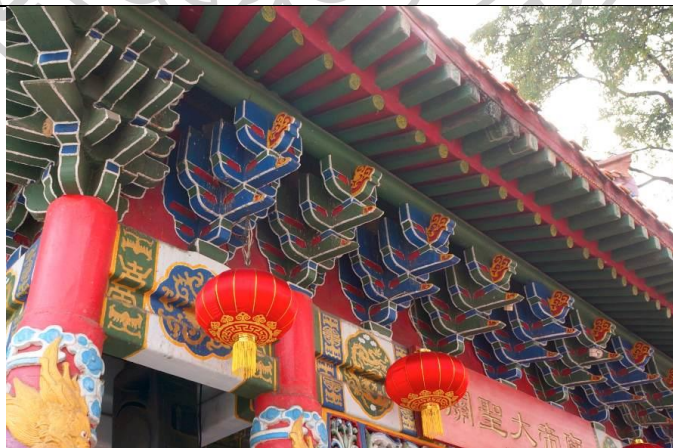
ภาพที่ 53 ส่วนรองรับหลังคาที่ศาลเจ้ากวนอู (มูลนิธิศรัทธาธรรมเชียงใหม่)
