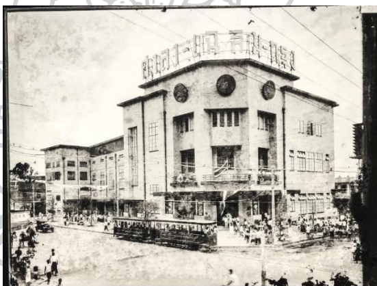
ภาพที่ 54 ศาลาเฉลิมกรุง บริเวณถนนตรีเพชรตัดกับถนนเจริญกรุง เมื่อ พ.ศ. 2476 ( 1933 ) ภาพถ่ายนี้ถ่ายในรัชสมัยรัชกาลที่ 7 ที่มาภาพ https://www.prachachat.net/spinoff/lifestyle/news-489762
