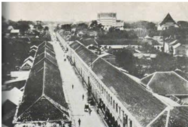
ภาพที่ 73 อาคารตึกแถวถนนบำรุงเมือง
