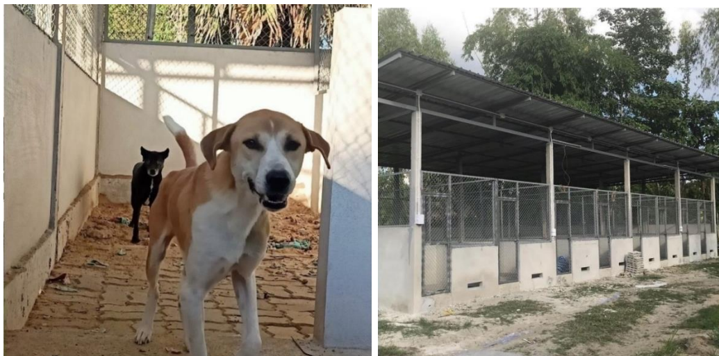
ภาพที่ 90 การดำเนินงานปลูกสร้างศูนย์พักพิงเอกชน อำเภอสันกำแพง จังหวัดเชียงใหม่ (โดย ยศพร จันทองจีน เมื่อ 22 สิงหาคม 2564)
