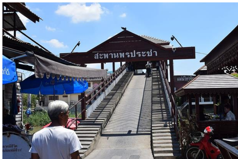
รูปภาพที่ 6 สะพานข้ามแม่น้ำ ตลาด 100 ปี อ.สามชุก จ.สุพรรณบุรี
