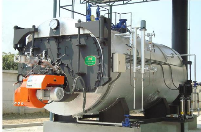
รูปที่ 19 หม้อไอน้ำแบบท่อไฟ
