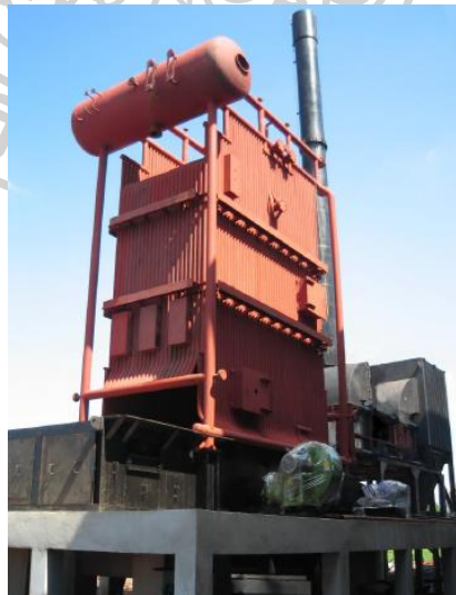
รูปที่ 20 หม้อไอน้ำแบบท่อน้ำ
