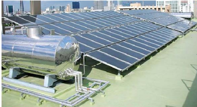
รูปที่ 17 ระบบผลิตน้ำร้อนโดยใช้พลังงานแสงอาทิตย์แบบผสมผสาน ที่มา : Thaienergysaving, SUNSAV [16]
