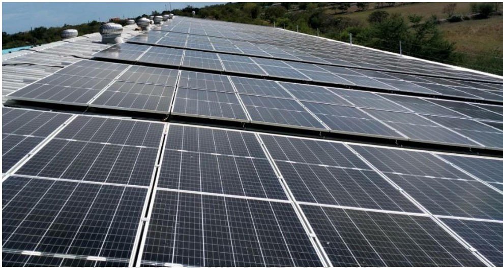
รูปที่ 68 แผงเซลล์แสงอาทิตย์ Bifacial Dual Glass Cat Mono Module
