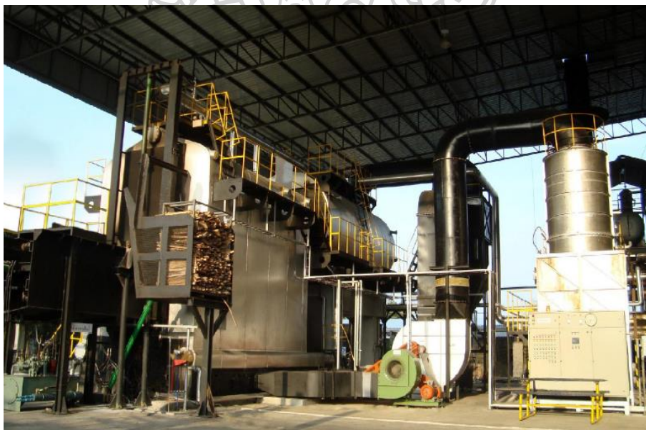
รูปที่ 21 หม้อไอน้ำแบบผสม
