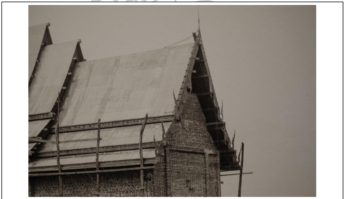
ภาพที่ 13 ภาพถ่ายหลังคาและเครื่องลำยองวัดเบญจมบพิตรขณะก่อสร้าง สังเกตเครื่องลำยองทำด้วยไม้อัด ที่มา สำนักหอจดหมายเหตุแห่งชาติ, เฉลิมฟิล์มกระจก ฉลองมรดกความทรงจำแห่งโลก , 204.
