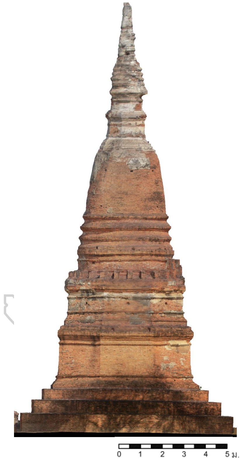
ภาพที่ 112 รูปด้านทิศตะวันตก เจดีย์ประธาน วัดจงกลม จากการรังวัดด้วยภาพ (Photogrammetry)
