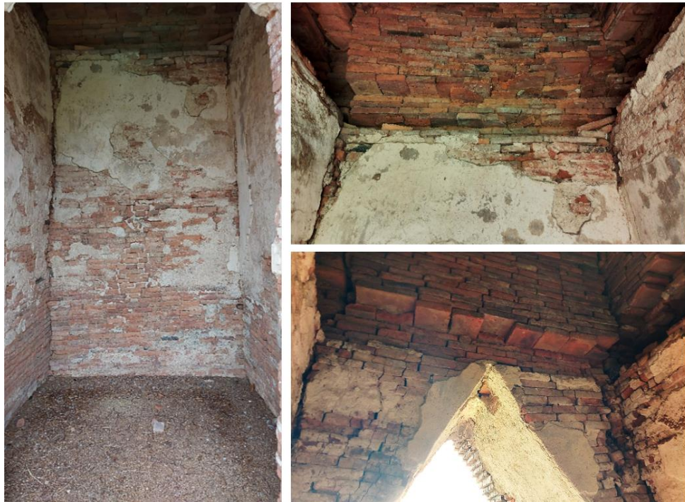
ภาพที่ 52 เทคนิคการก่อสร้างภายในห้องเรือนธาตุ เจดีย์รายของคันทิไต้ ข้างอุโบสถ วัดมหาธาตุ
