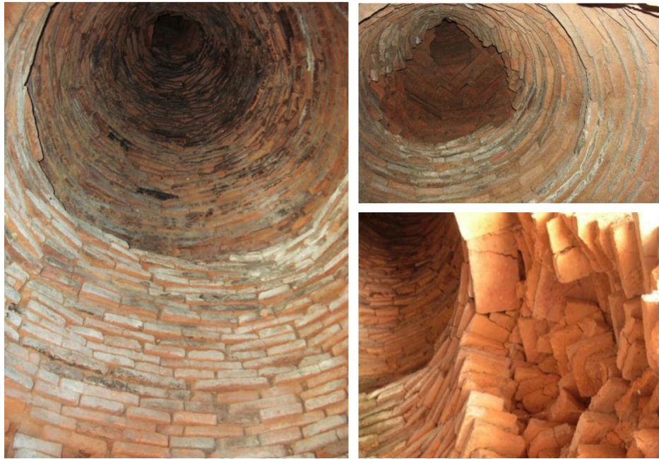
ภาพที่ 119 เทคนิคการก่อสร้างเหนือห้องเรือนธาตุเจดีย์ราย วัดสุวรรณवास
