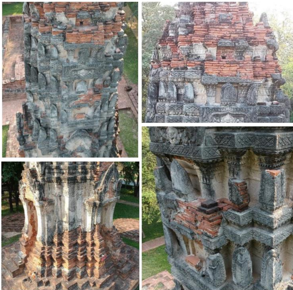
ภาพที่ 4 เทคนิคการก่อสร้างรอบองค์เจดีย์ประธาน วัดส้ม
