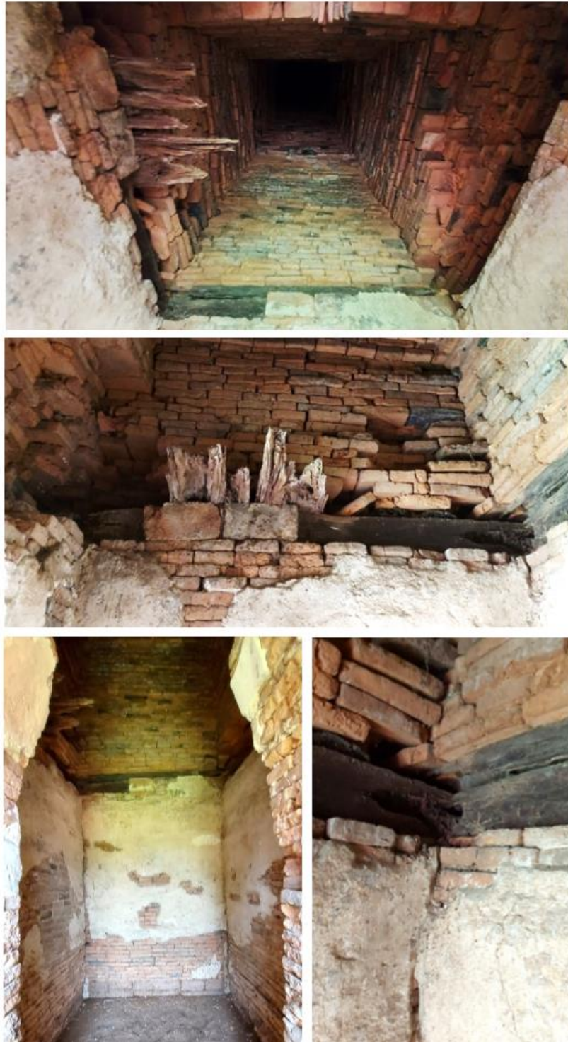
ภาพที่ 63 เทคนิคการก่อสร้างภายในห้องเรือนธาตุองค์ทิศเหนือ ข้างอุโบสถวัดมหาธาตุ
