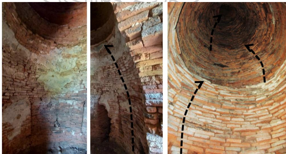
ภาพที่ 148 ผนังกำแพงรับน้ำหนักแบบก่อสั่นเหลื่อมโค้งในผนังโครงสร้างรูปวงกลม
