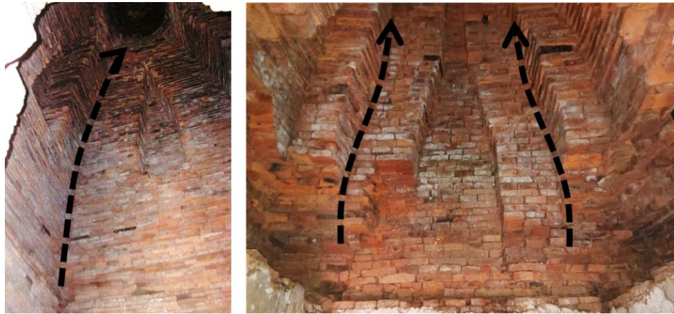
ภาพที่ 147 ผนังกำแพงรับน้ำหนักแบบก่อสั่นเหลื่อมโค้ง ในผนังโครงสร้างรูปสี่เหลี่ยมและสี่เหลี่ยมเพิ่มมุม
