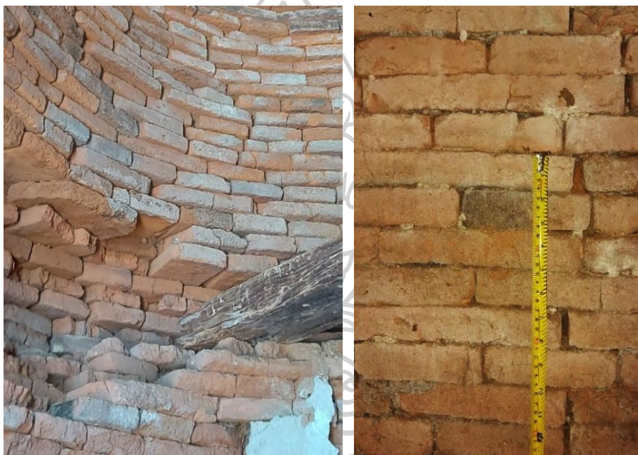
ภาพที่ 142 ตัวอย่างการก่ออิฐแบบไม่สอปูน (ซ้าย) และการสอวัสดุคล้ายดินโคลนบาง ๆ ระหว่างชั้นอิฐ (ขวา)
