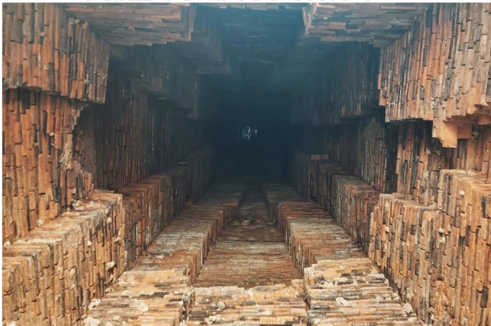
ภาพที่ 19 เทคนิคการก่อสร้างส่วนเหนือห้องเรือนธาตุเจดีย์ประธานวัดลังกา (ต่อ)
