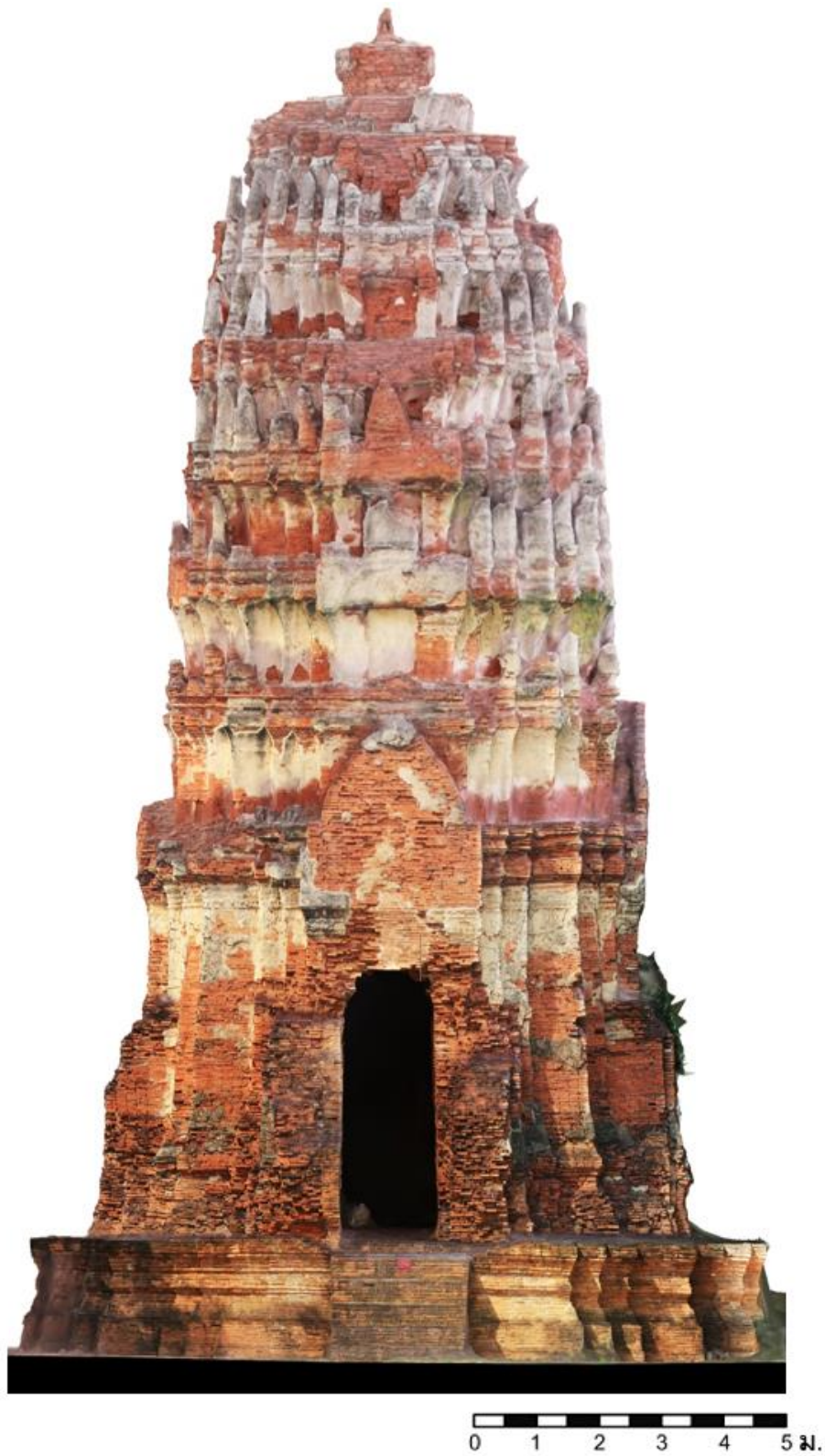
ภาพที่ 21 รูปด้านทิศตะวันออก เจดีย์ประธาน วัดลิงกา จากการรังวัดด้วยภาพ (Photogrammetry)
