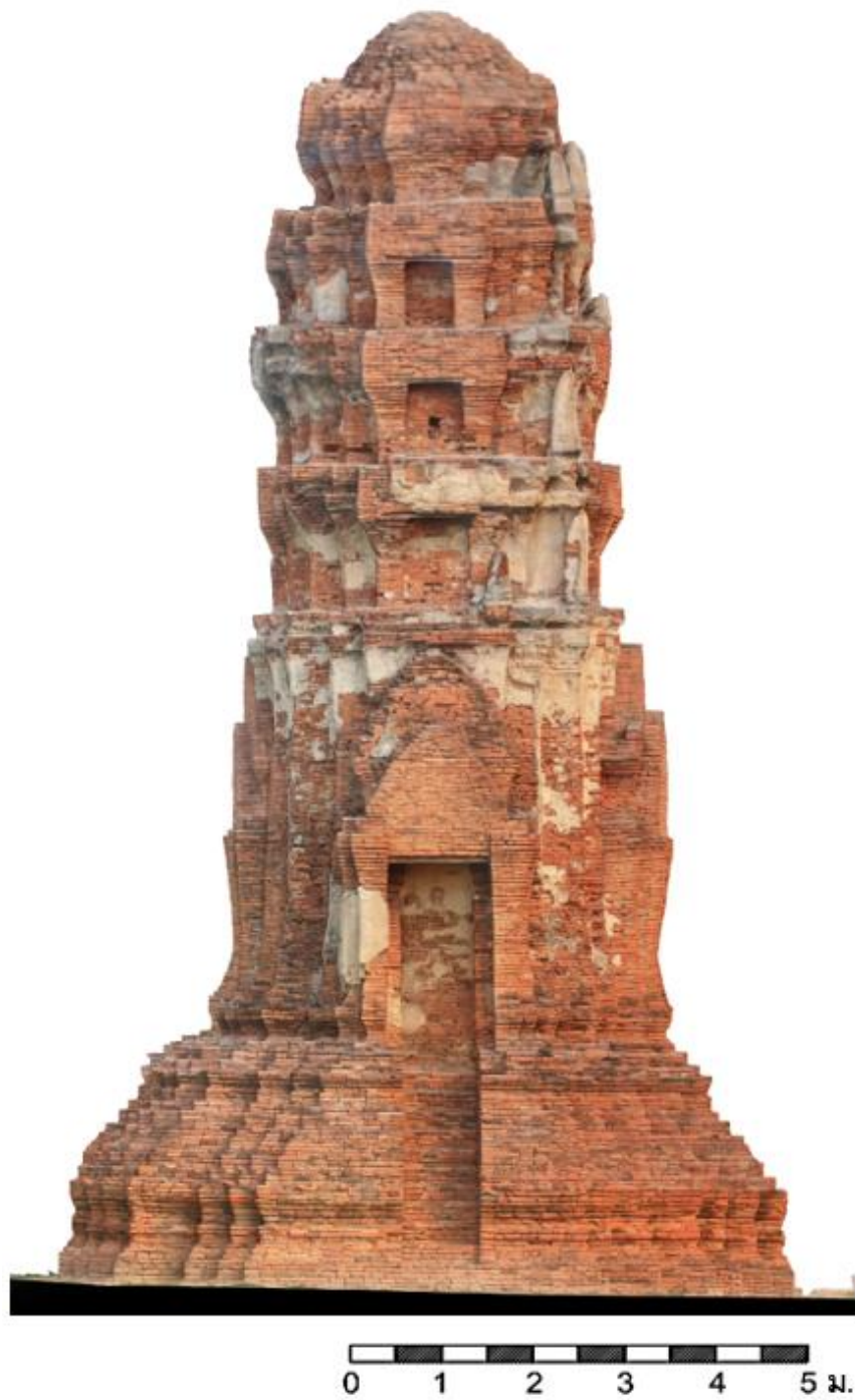
ภาพที่ 56 รูปด้านทิศใต้ เจดีย์รายองค์ทิศใต้ ข้างอุโบสถวัดมหาธาตุ จากการรังวัด ด้วยภาพ (Photogrammetry)
