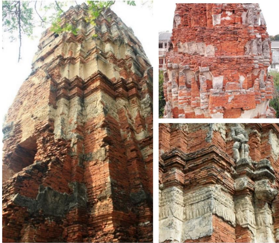
ภาพที่ 15 เทคนิคการก่อสร้างรอบองค์เจดีย์ประธาน วัดลังกา
