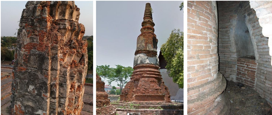
ภาพที่ 169 การปรับเปลี่ยนรูปแบบเจดีย์ภายหลังการก่อสร้างแล้วเสร็จ เจดีย์ประธาน วัดโลกยสุทธา (ซ้าย) เจดีย์ราย วัดพุทธโธศวรรย์ (กลาง) และการก่อเจดีย์ครอบทับองค์ เจดีย์เดิมที่เจดีย์ประธานวัดจงกลม (ขวา)
