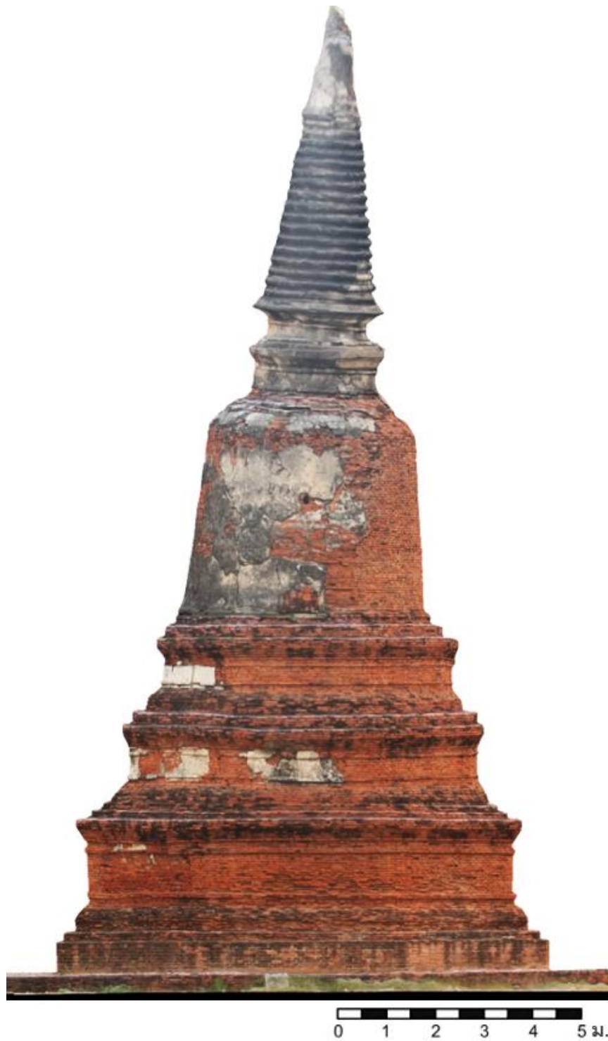
ภาพที่ ๑๑ รูปด้านทิศตะวันตก เจดีย์ประธาน วัดหลังคาขาว จากการรังวัดด้วยภาพ (Photogrammetry)
