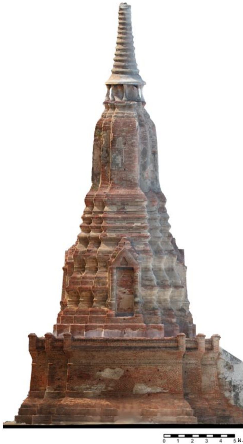
ภาพที่ 133 รูปด้านทิศตะวันออก เจดีย์ประธาน วัดใหม่ประชุมพล จากการรังวัดด้วยภาพ (Photogrammetry)
