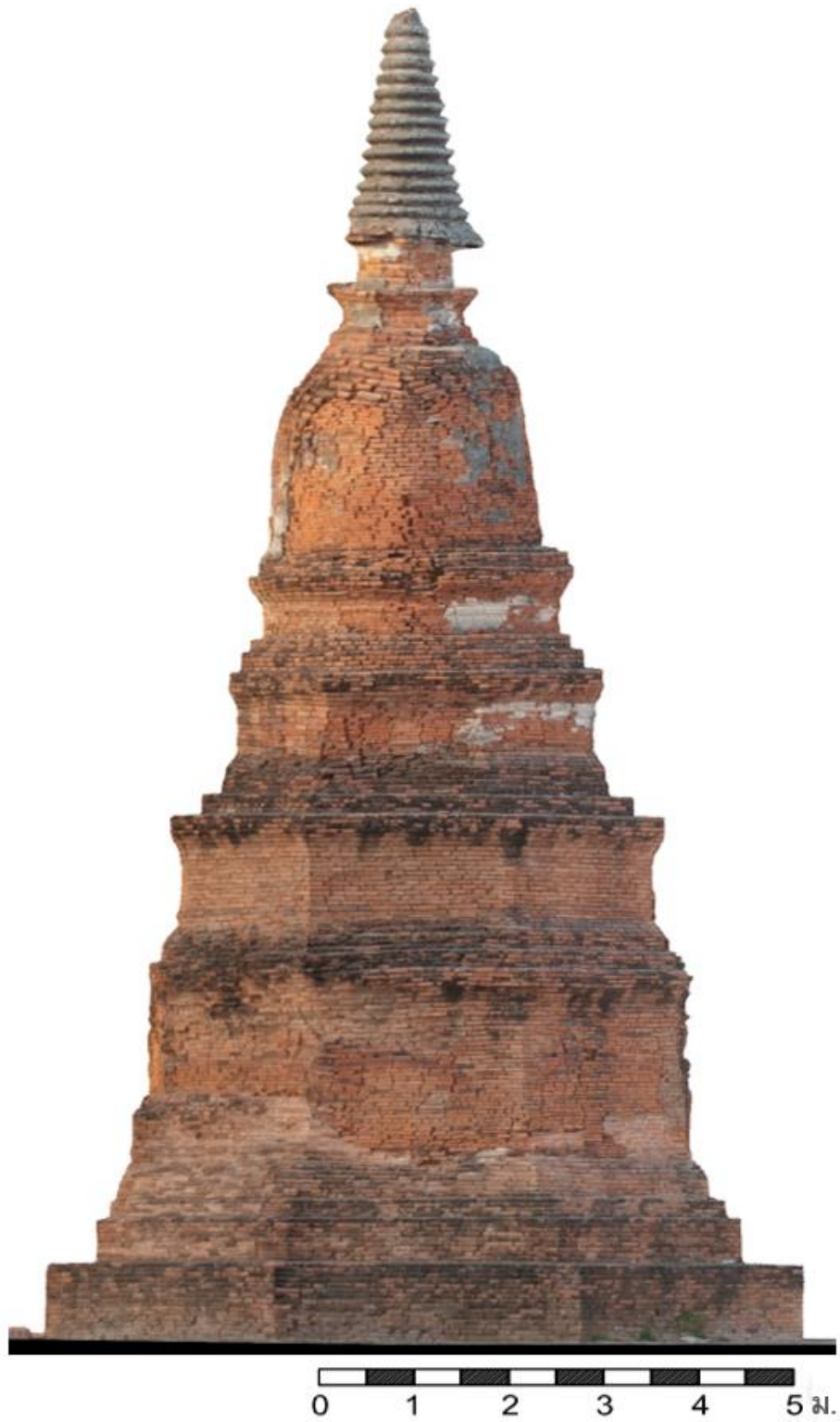
ภาพที่ 122 รูปด้านทิศใต้ เจดีย์ราย วัดสุวรรณาวาส จากการรังวัดด้วยภาพ (Photogrammetry)
