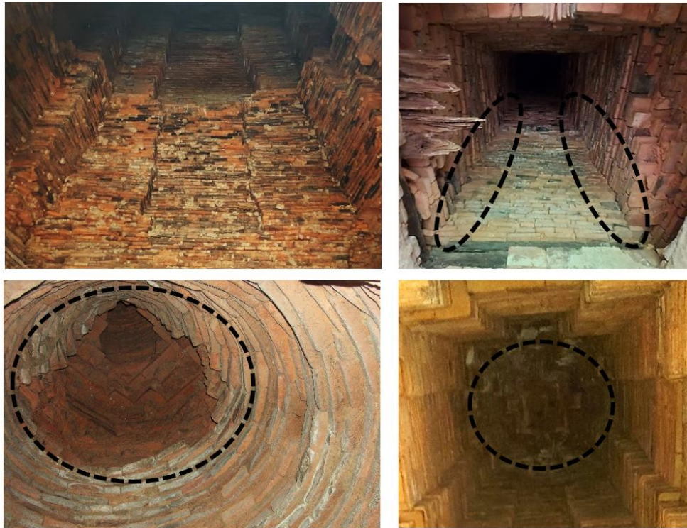
ภาพที่ 152 รูปแบบผนังกำแพงรับน้ำหนักแบบก่อส้นเหลี่ยมไม่เป็นระเบียบ
