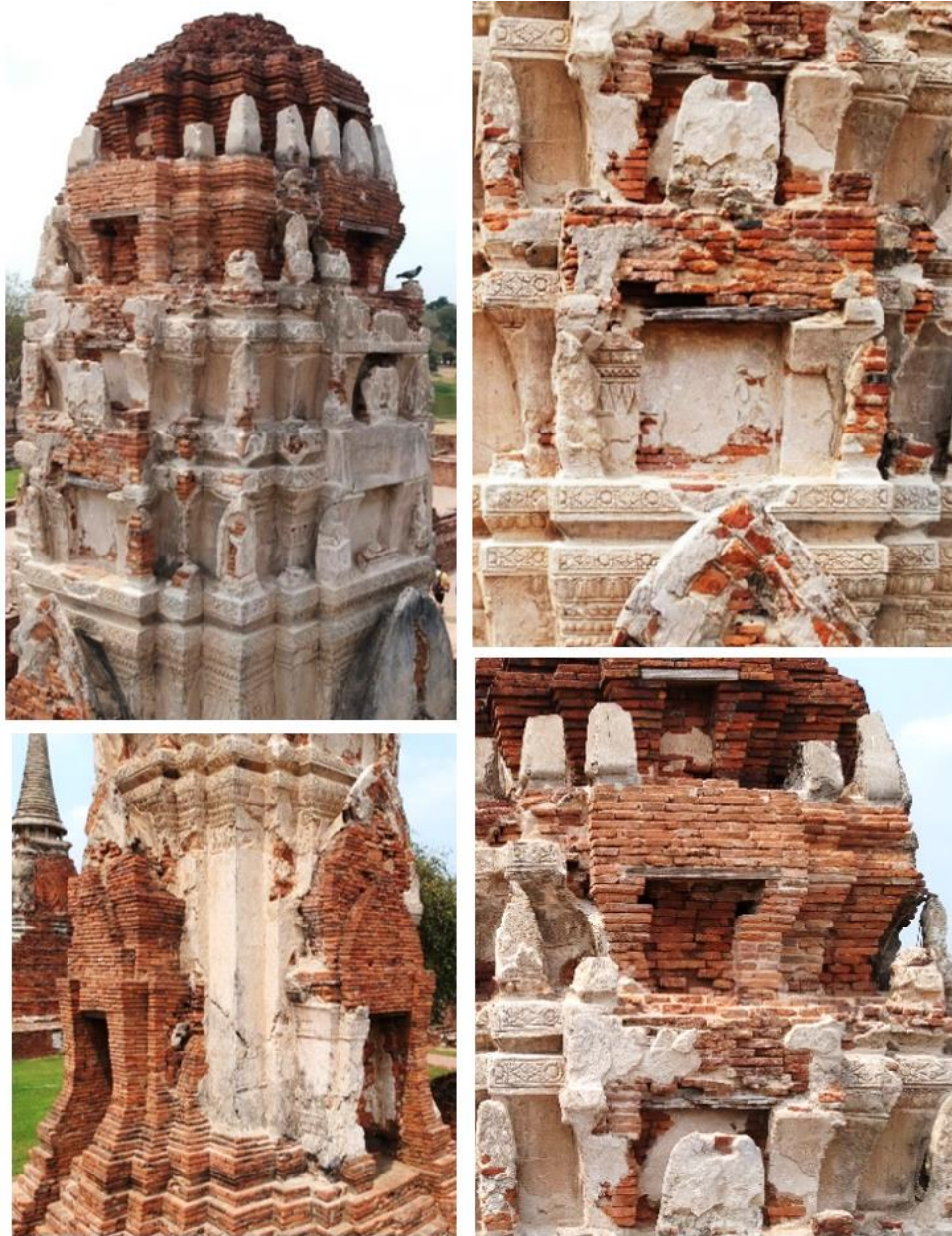
ภาพที่ 62 เทคนิคการก่อสร้างโดยรอบองค์เจดีย์รายองค์ทิศเหนือ ข้างอุโบสถวัดมหาธาตุ
