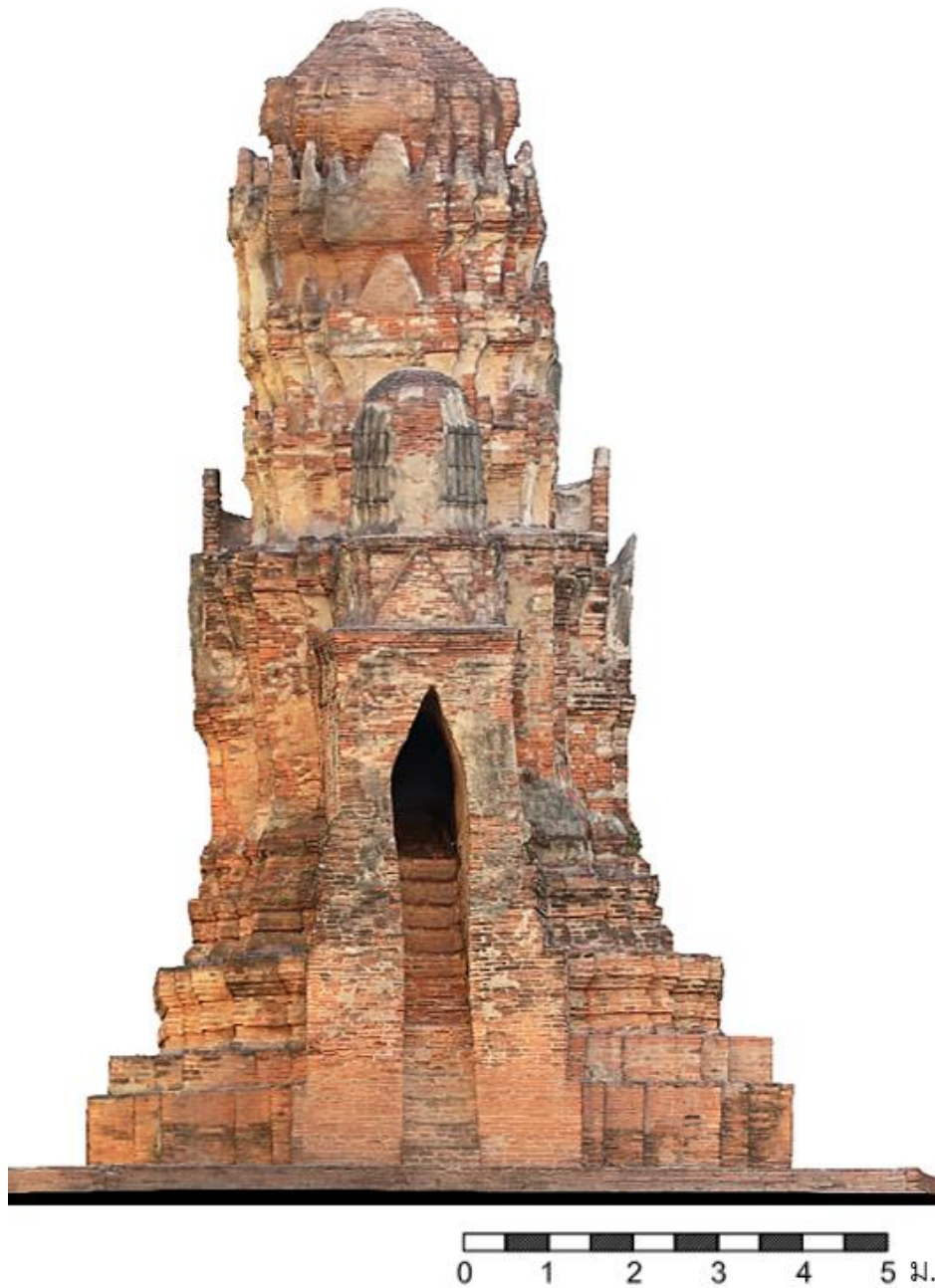
ภาพที่ 44 รูปด้านทิศตะวันออก เจดีย์ประธาน วัดนก จากการรังวัดด้วยภาพ (Photogrammetry)
