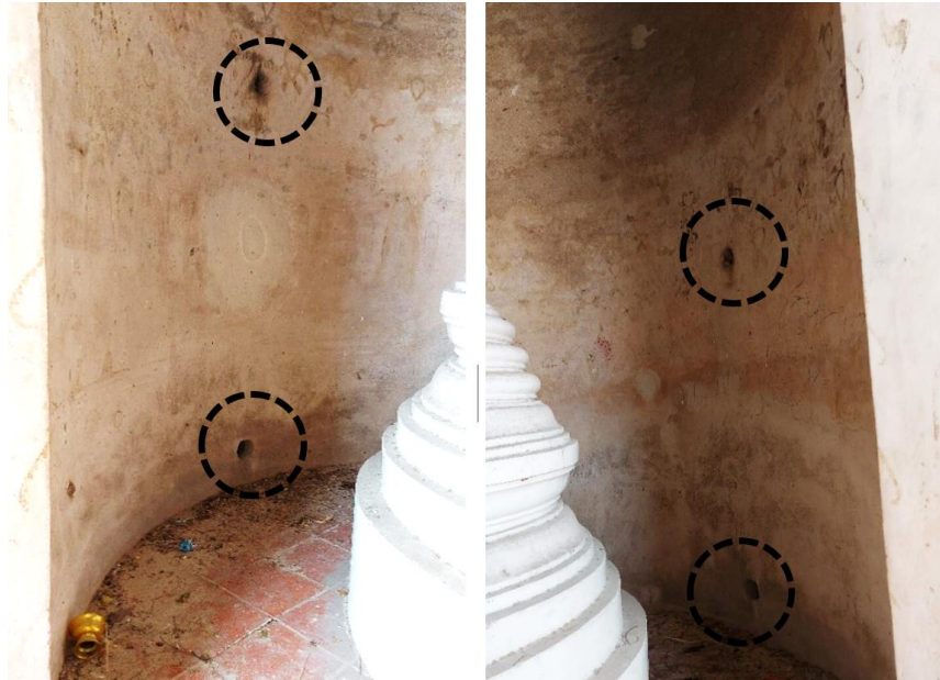
ภาพที่ 130 เทคนิคการก่อสร้างภายในห้องเรือนธาตุ เจดีย์ประธาน วัดใหม่ประชุมพล
