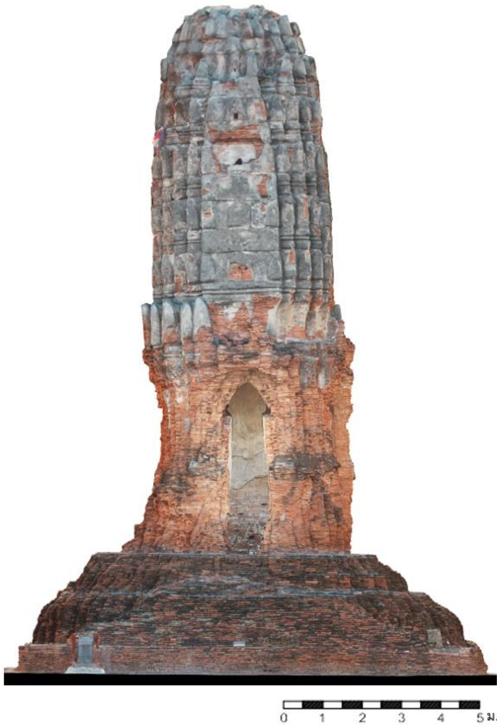
ภาพที่ 33 รูปด้านทิศตะวันออก เจดีย์ประธาน วัดโลกยสุทธา จากการรังวัดด้วยภาพ (Photogrammetry)
