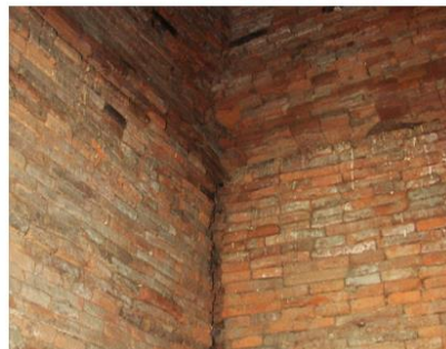
ภาพที่ 73 เทคนิคการก่อสร้างภายในห้องเรือนธาตุ เจดีย์รายองค์ด้านทิศตะวันออกเฉียงใต้ วัดราชบูรณะ
