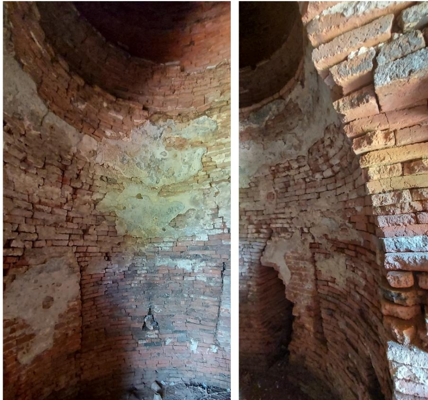
ภาพที่ 94 เทคนิคการก่อสร้างภายในห้องเรือนธาตุ เจดีย์ประธาน วัดหลังคาขาว
