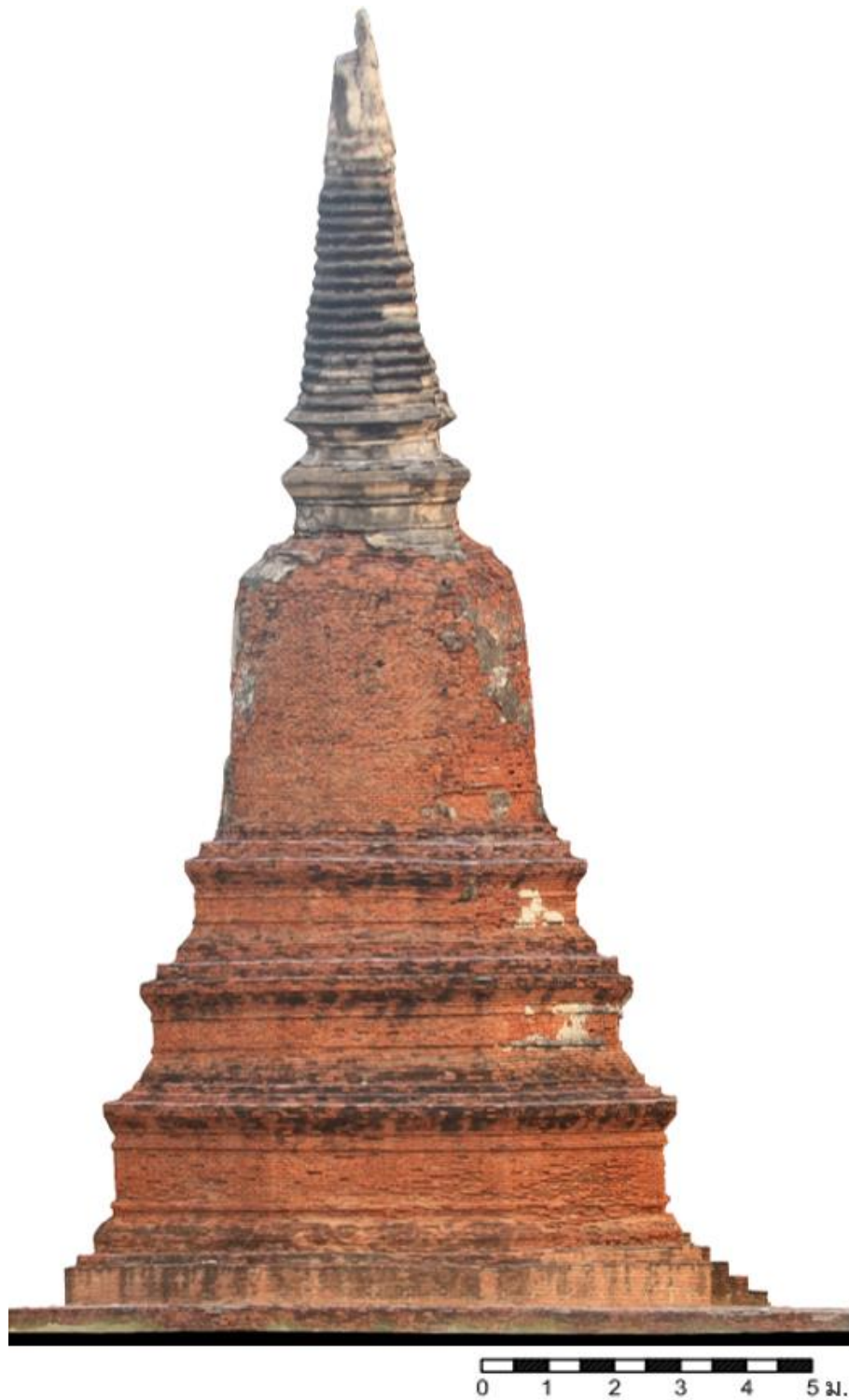
ภาพที่ ๑๘ รูปด้านทิศใต้ เจดีย์ ประฐานวัดหลังคาขาว จากการรังวัดด้วยภาพ (Photogrammetry)
