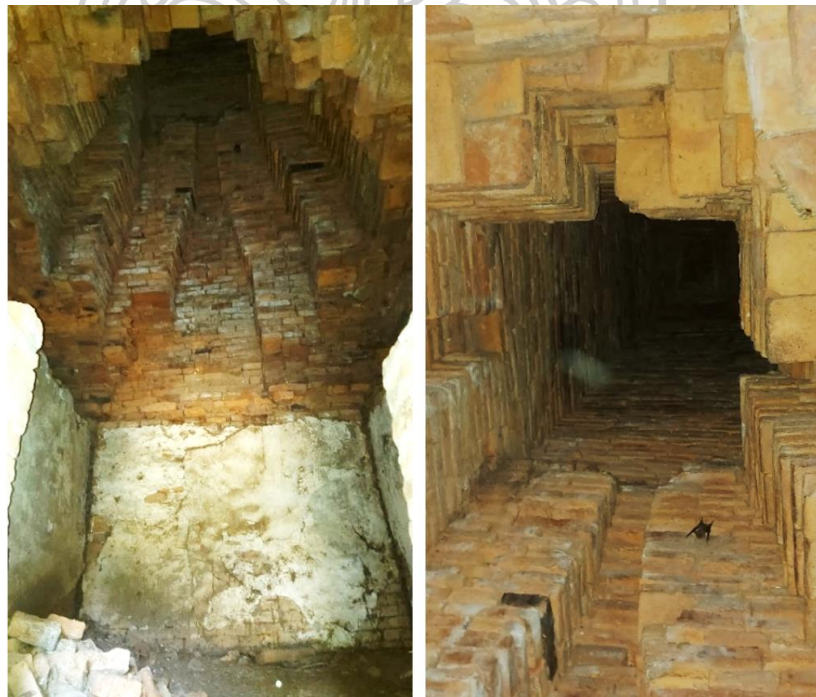
ภาพที่ 41 เทคนิคการก่อสร้างภายในห้องเรือนธาตุเจดีย์ประธาน วัดนก
