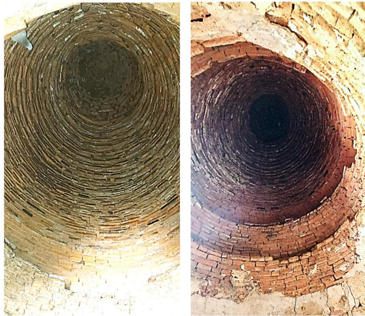
ภาพที่ 95 เทคนิคการก่อสร้างเหนื่อห้องเรือนธาตุ เจดีย์ประธาน วัดหลังคาขาว
