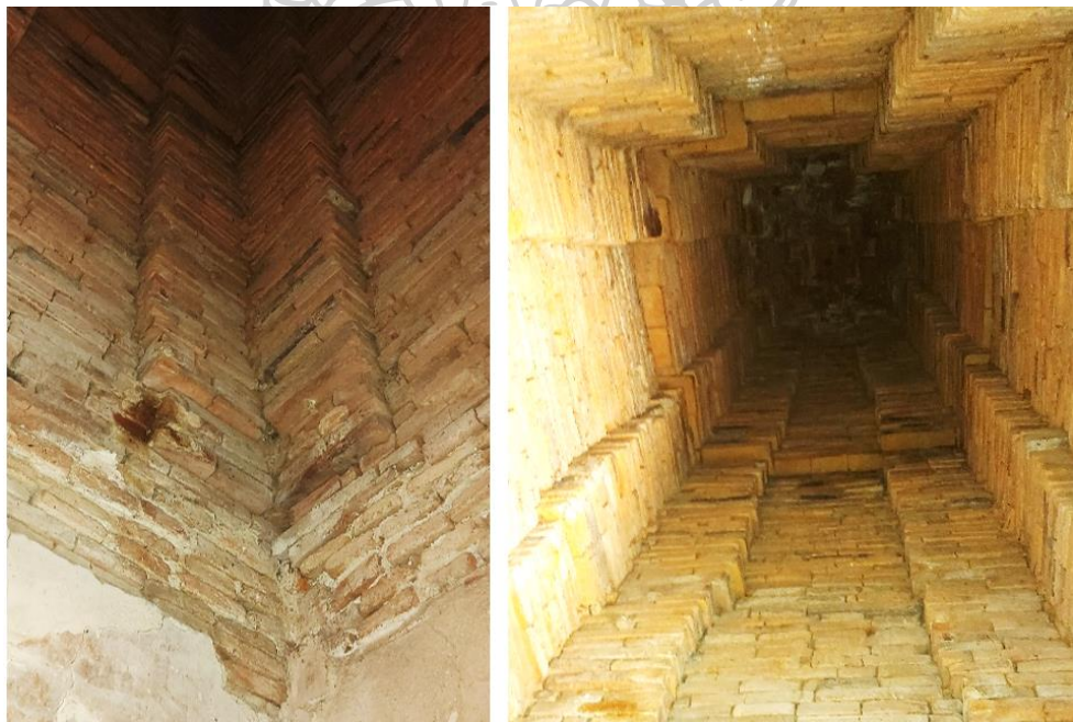
ภาพที่ 6 เทคนิคการก่อสร้างส่วนเหนือห้องเรือนธาตุเจดีย์ประธาน วัดสัม
