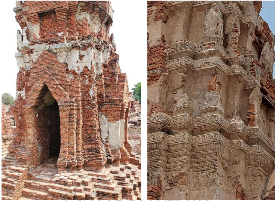
ภาพที่ 51 เทคนิคการก่อสร้างรอบเจดีย์รายของคันทิไต้ ข้างอุโบสถวัดมหาธาตุ
