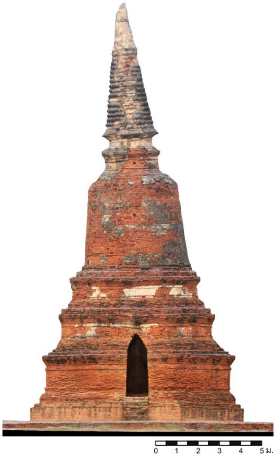
ภาพที่ 97 รูปด้านทิศตะวันออก เจดีย์ประธาน วัดหลังคาขาว จากการรังวัดด้วยภาพ (Photogrammetry)
