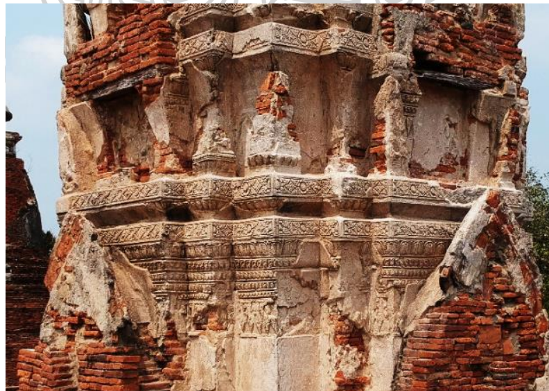
ภาพที่ 170 ตัวอย่างการฉาบปูนปิดทับลายปูนปั้นเดิมที่เจดีย์รายองค์ทิศเหนือข้างอุโบสถ วัดมหาธาตุ
