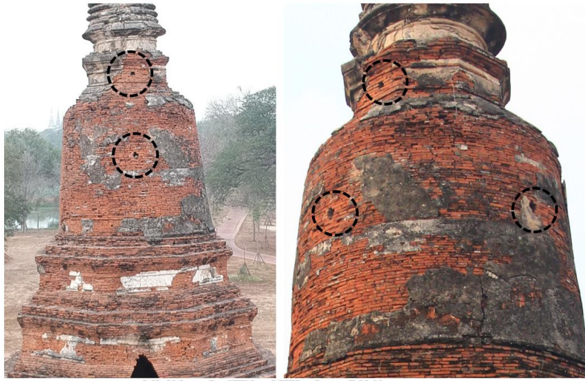
ภาพที่ 93 เทคนิคการก่อสร้างรอบองค์เจดีย์ประธาน วัดหลังคาขาว
