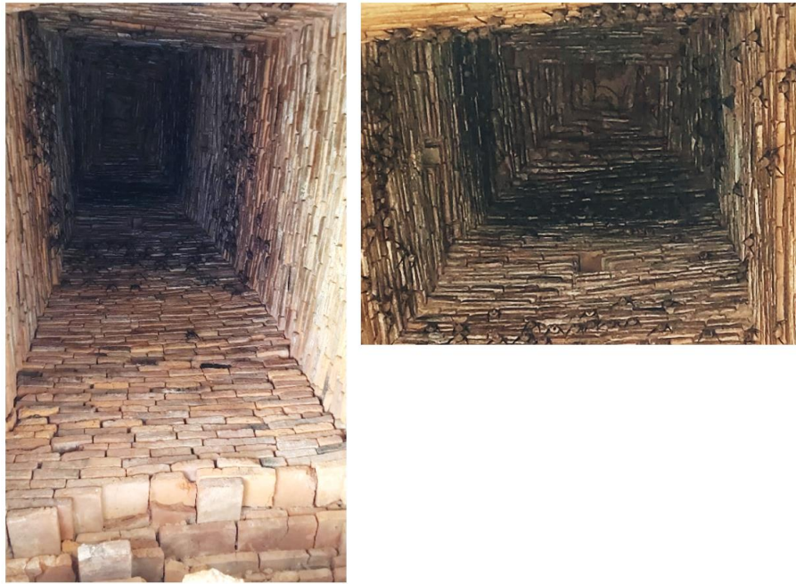
ภาพที่ 53 เทคนิคการก่อสร้างส่วนเหนือห้องเรือนธาตุ เจดีย์รายองค์ทิศใต้ ข้างอุโบสถ วัดมหาธาตุ
