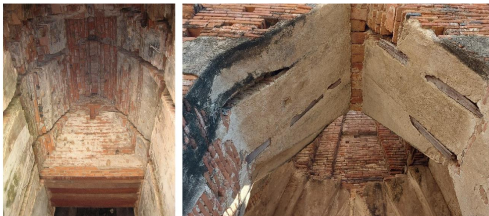
ภาพที่ 151 ไม้แบบในผนังกำแพงรับน้ำหนักแบบก่อส้นเหลี่ยมโค้งที่มุขทางเข้าเจดีย์ ประธานวัดไชยวัฒนาราม (ซ้าย) และที่ปราสาททิศ ปราสาทนครหลวง (ขวา)
