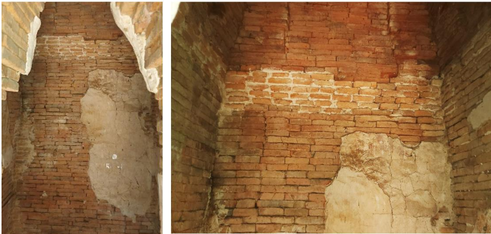
ภาพที่ 5 เทคนิคการก่อสร้างภายในห้องเรือนธาตุเจดีย์ประธาน วัดสัม
