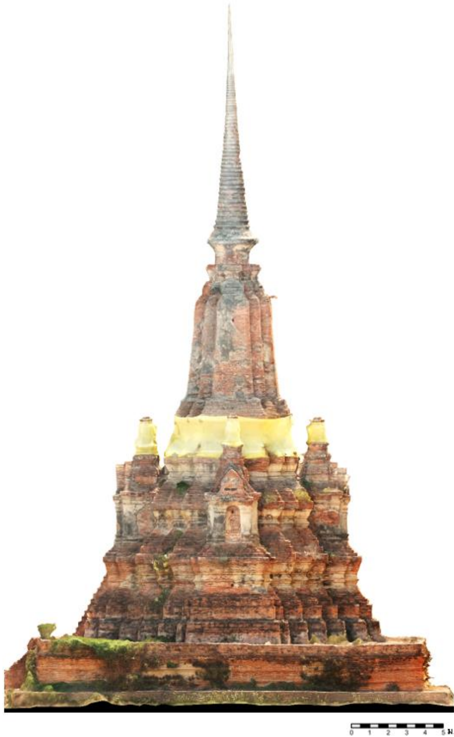
ภาพที่ 89 รูปด้านทิศเหนือ เจดีย์ประธาน วัดญาณเสน จากการรังวัดด้วยภาพ (Photogrammetry)
