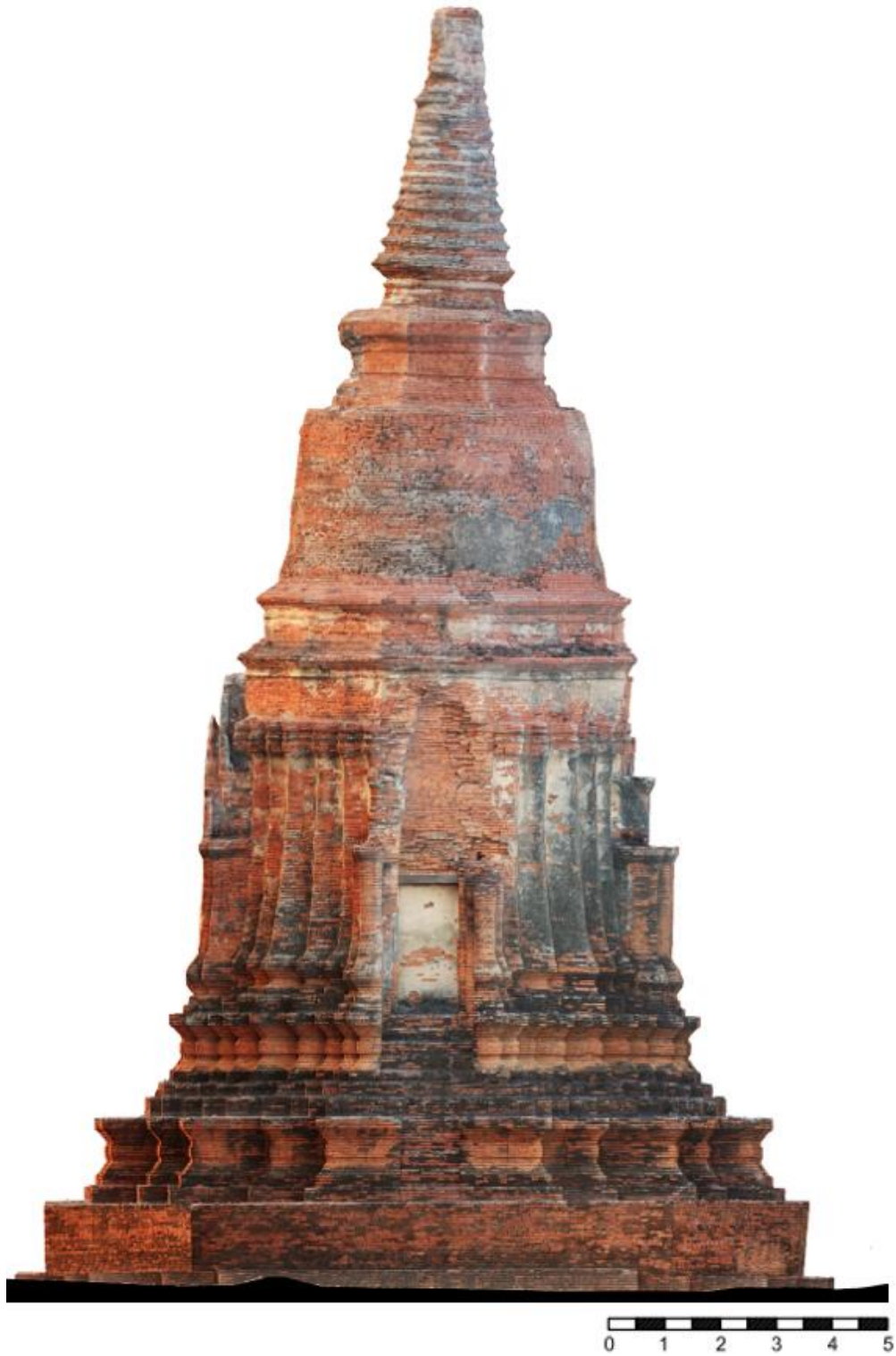
ภาพที่ 79 รูปด้านทิศเหนือ เจดีย์รายของคัณฑ์ด้านทิศตะวันออกเฉียงใต้ วัดราชบูรณะ จากการ รังวัดด้วยภาพ (Photogrammetry)
