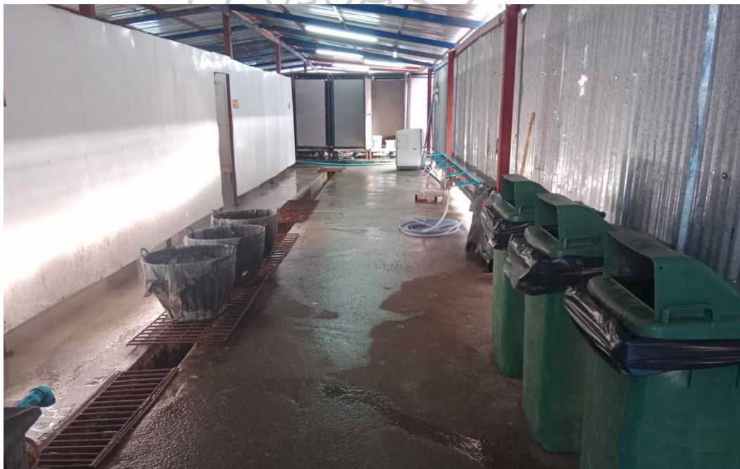
รูปภาพที่ 4.21 แนวรางระบายน้ำภายในห้องน้ำของ โครงการ ข
