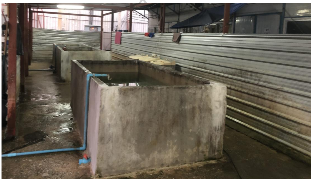
รูปภาพที่ 4.22 เปลี่ยนจากอ่างอาบน้ำรวมกันเป็นอ่างเก็บน้ำใช้ของ โครงการ ค
