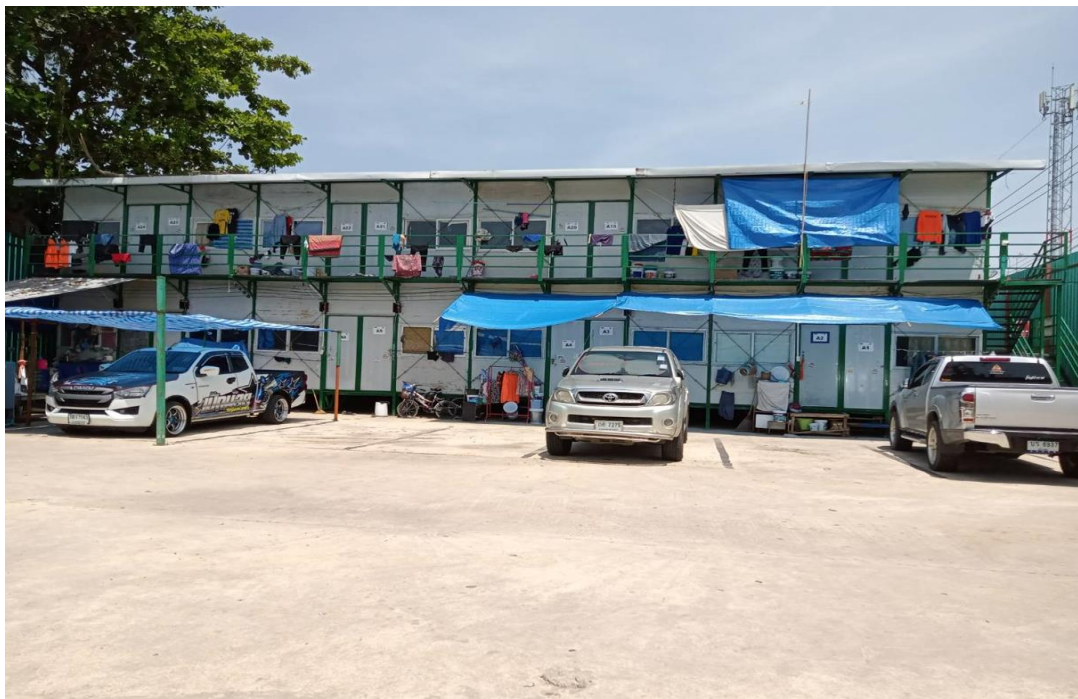
รูปภาพที่ 4.16 การปรับพื้นที่บริเวณถนนหน้าที่พักแรงงานก่อสร้างของ โครงการ ค
