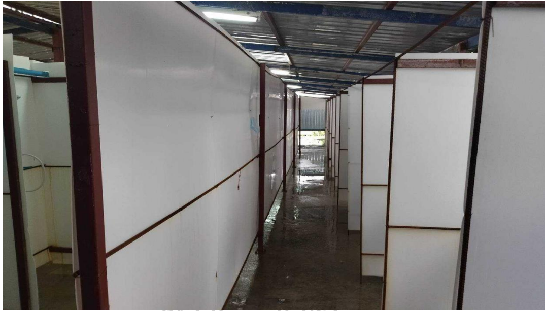
รูปภาพที่ 4.13 กั้นพื้นที่อาบน้ำและห้องน้ำของ โครงการ ข
