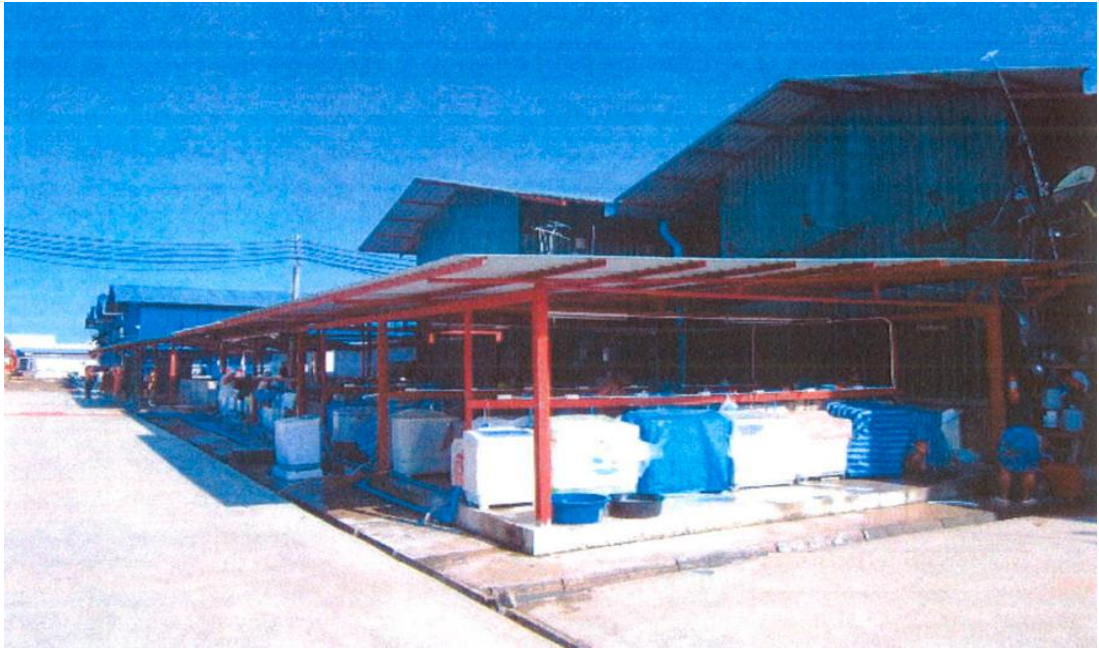
รูปภาพที่ 4.4 พื้นที่โซนเครื่องซักผ้าภายในที่พักอาศัยแรงงานก่อสร้างของ โครงการ ก
