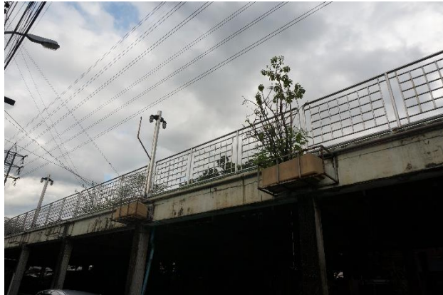
ภาพที่ 75 โครงเหล็กสำหรับปลูกต้นไม้ ที่มา : ผู้ศึกษาวิจัย
