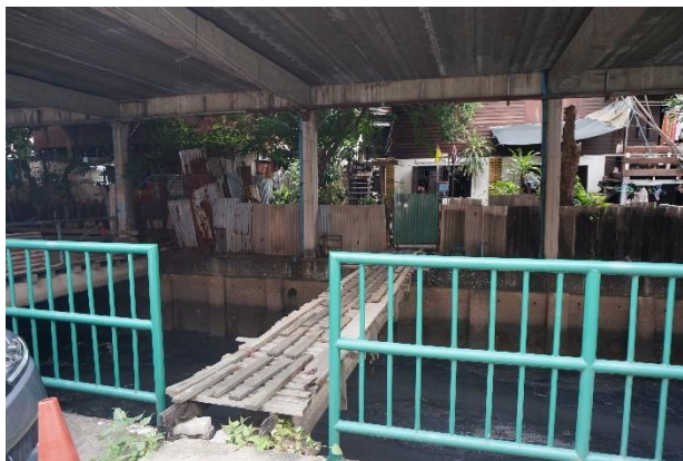
ภาพที่ 47 ทางเดินเข้าบ้านบริเวณใต้สะพาน
