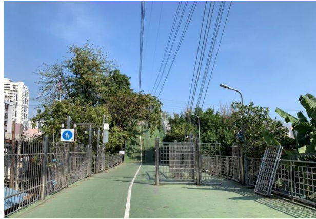
ภาพที่ 35 บริเวณทางขึ้น - ลงทำชุมชนจากด้านบนสะพานเขียว
