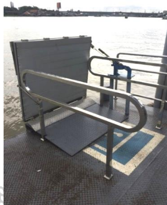
ภาพที่ 48 แผ่นทางลาดระหว่างหัวเรือกับท่า ตลาดประชานูทิศ 25
