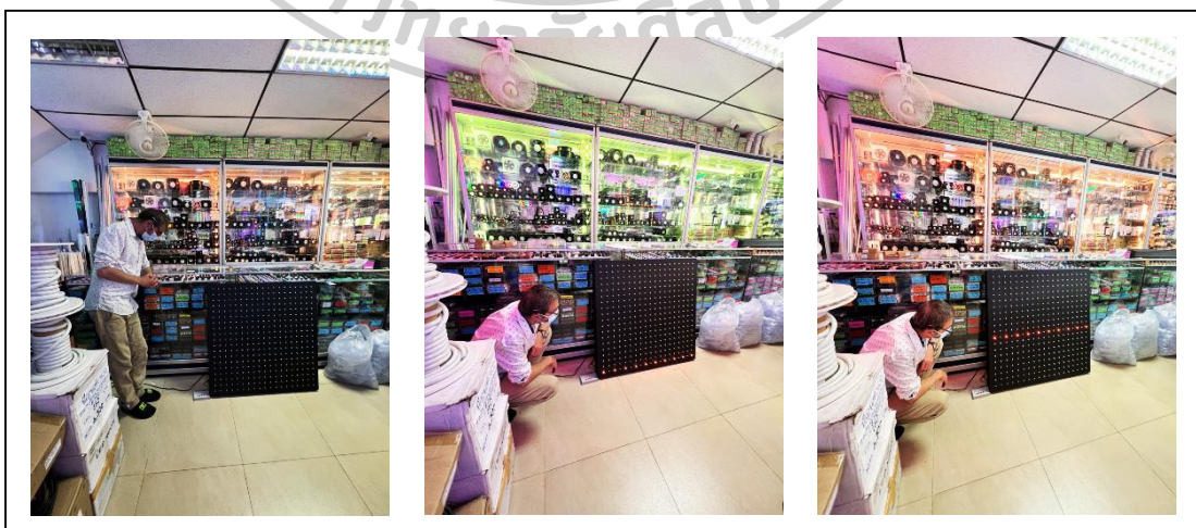
ภาพที่ 51 การตรวจสอบประสิทธิภาพของระบบการทำงานของงานระบบควบคุม
