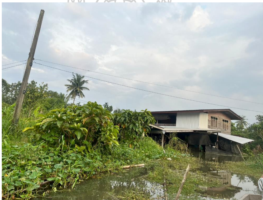
รูปภาพที่ 4 ภาพบริเวณหน้าบ้านดิตริมแม่น้ำท่าจีนของผู้สร้างสรรค์ ที่มา : ภาพจากผู้สร้างสรรค์, ตุลาคม 2565
